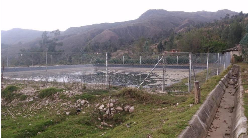
Foto N° 17. Reservorio Revestido Y Protegido Con Malla
