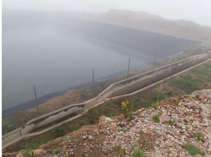
Foto N° 22. Estructura Del Desarenador
