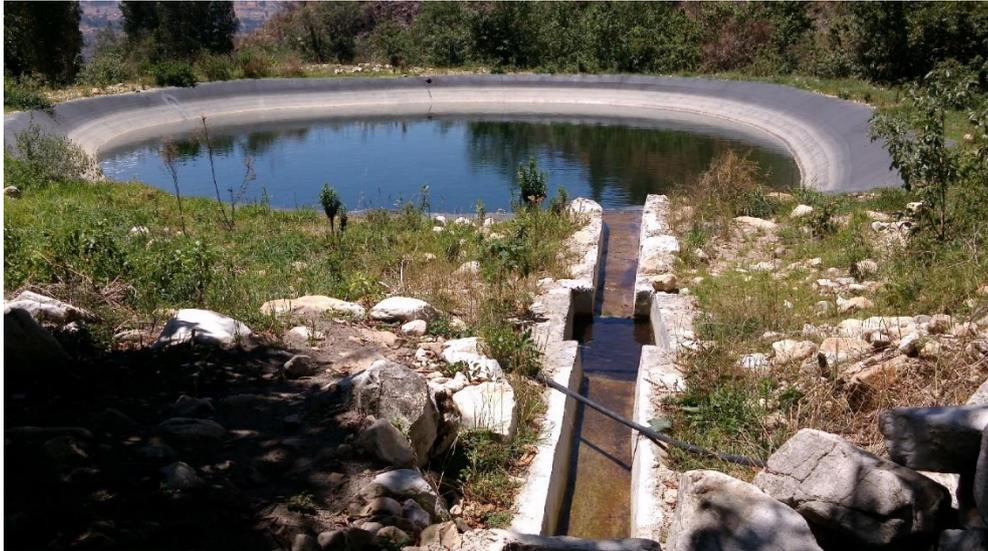
Foto N° 19. Reservorio Y Canal Revestido
