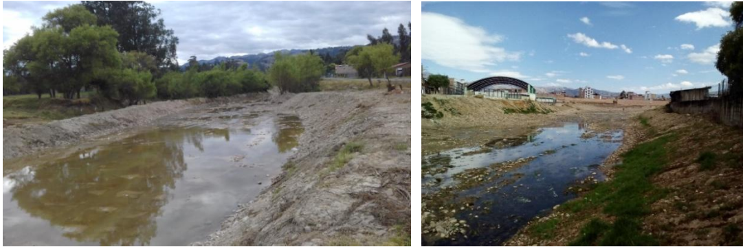
Figura N° 20 Río Chonta tramo de la cuenca baja.
