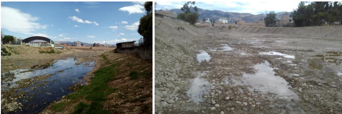
Figura N° 17 Tramo no encausado del río Chonta aguas arriba del puente Chonta.
