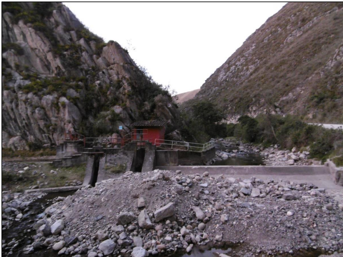
Figura 22. Vista general de la captación de la central hidroeléctrica “El Chicche”
