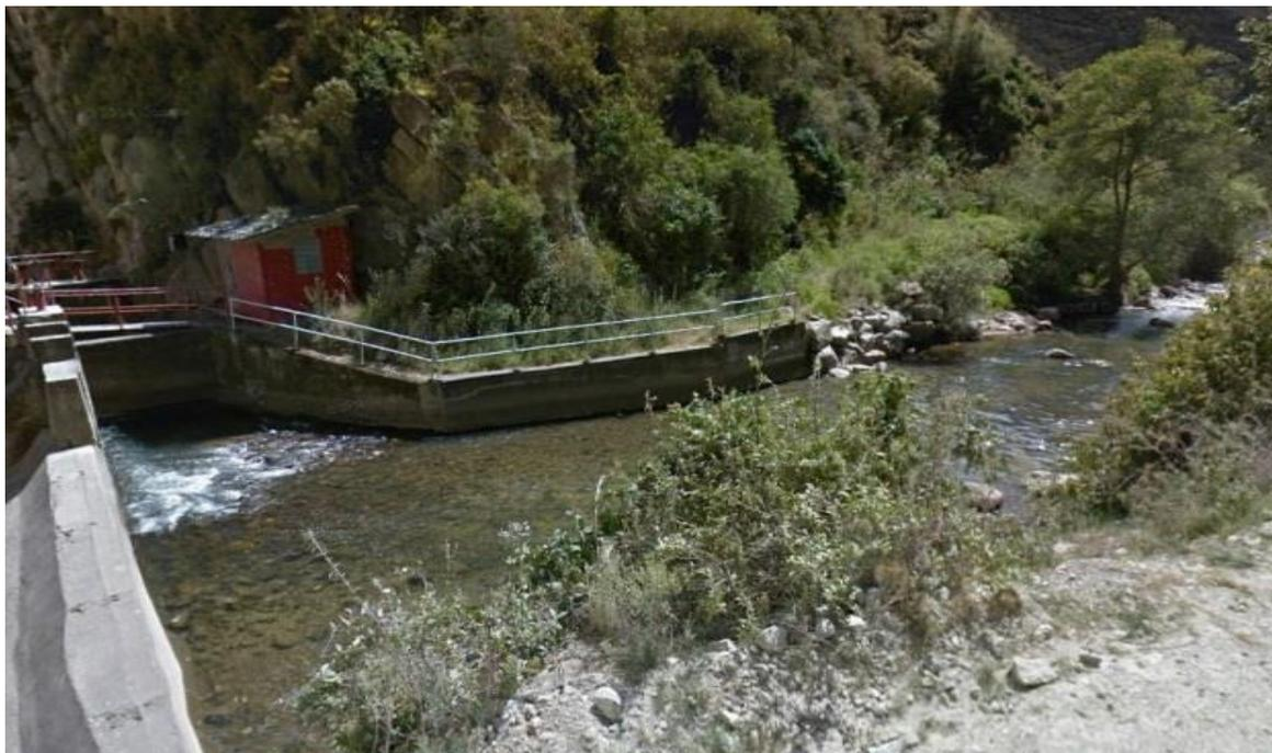
Figura 9. Sección de aforo del río Chonta aguas arriba de la captación El Chicche
