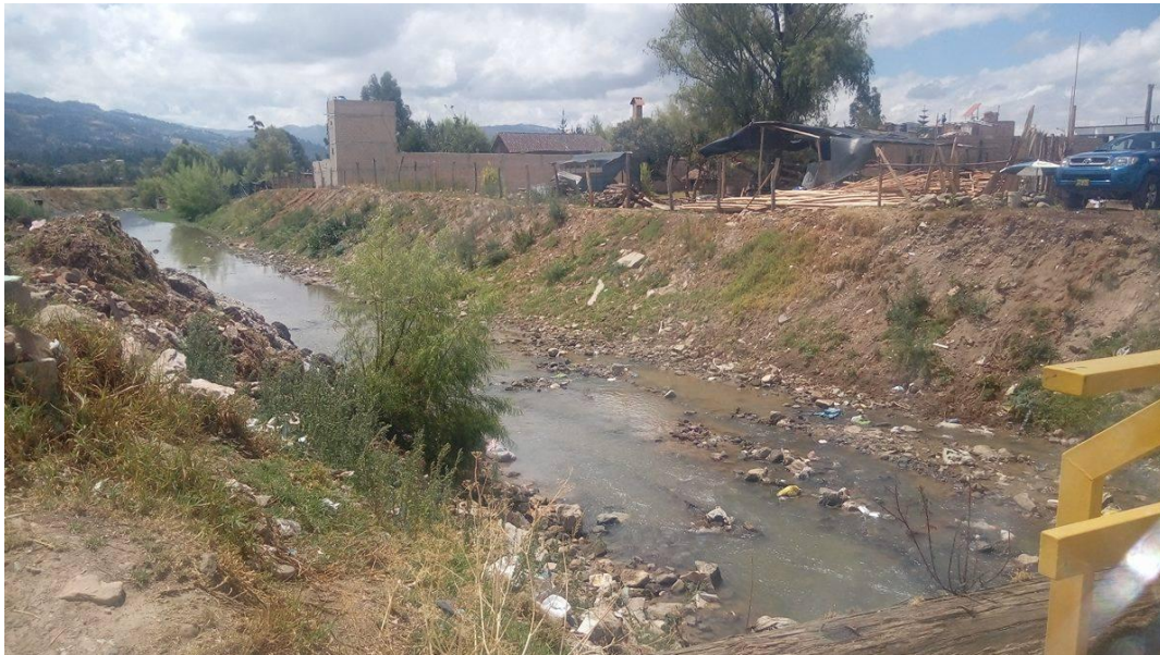
Figura 35: Tramo del Río Mashcón aguas arriba de la Captación Huacaríz
