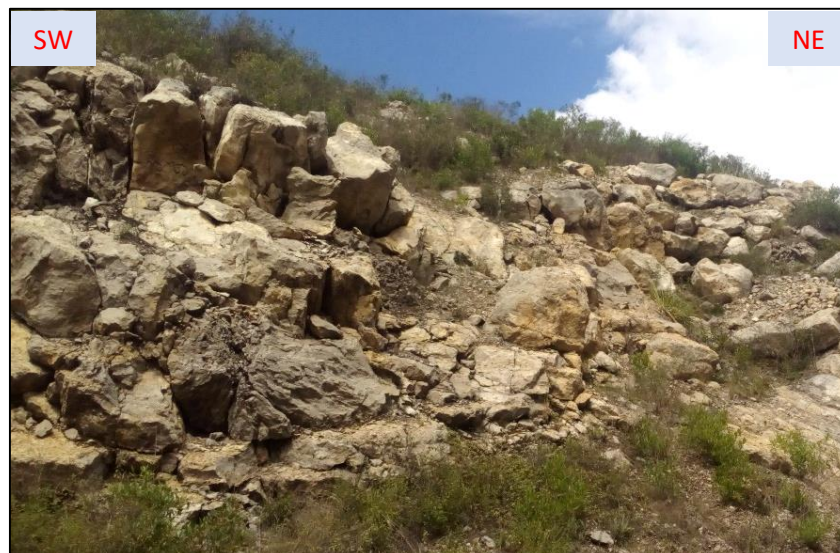
Foto 3.10: Depósitos Coluviales en el margen izquierdo del río Chotano. Coordenadas: E 749387, N 9274805, Cota 2148 m.s.n.m.
