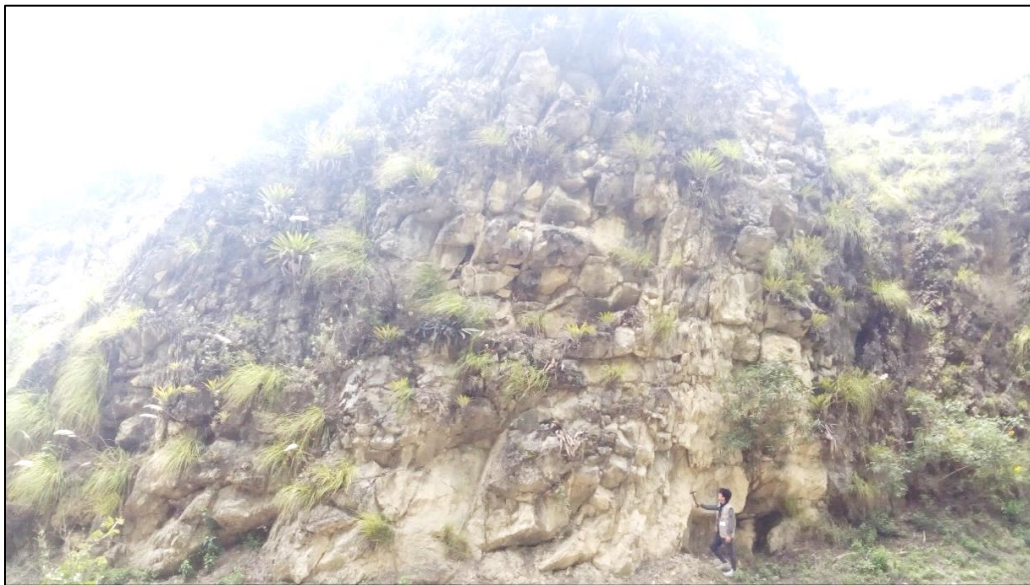
Foto 3.29: Afloramiento de calizas del Grupo Pulluicana en la progresiva Km 139+504 - Km 139+554.
