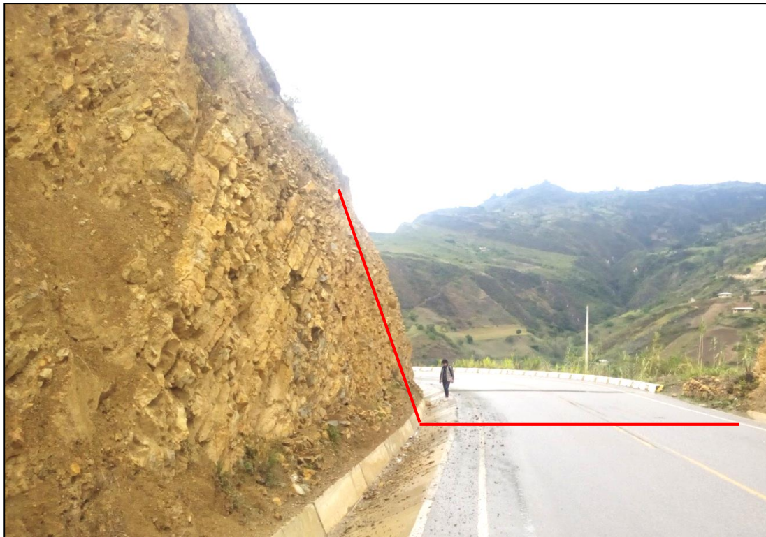
Foto 3.34: Perfil del talud en la progresiva Km 135+163.
