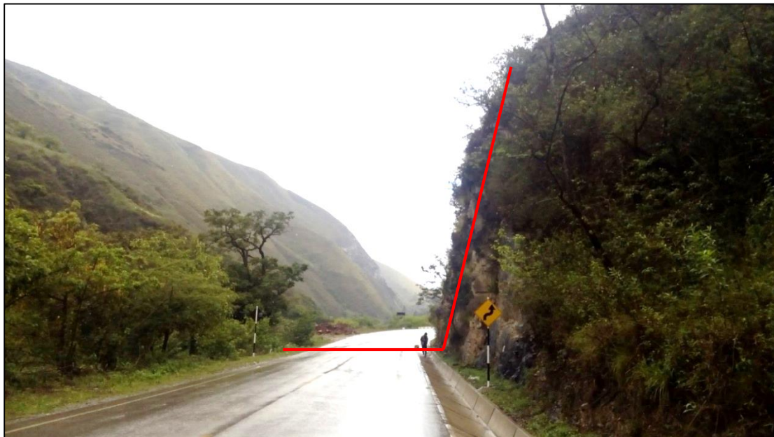
Foto 3.32: Perfil del talud en el Km 137+303.
