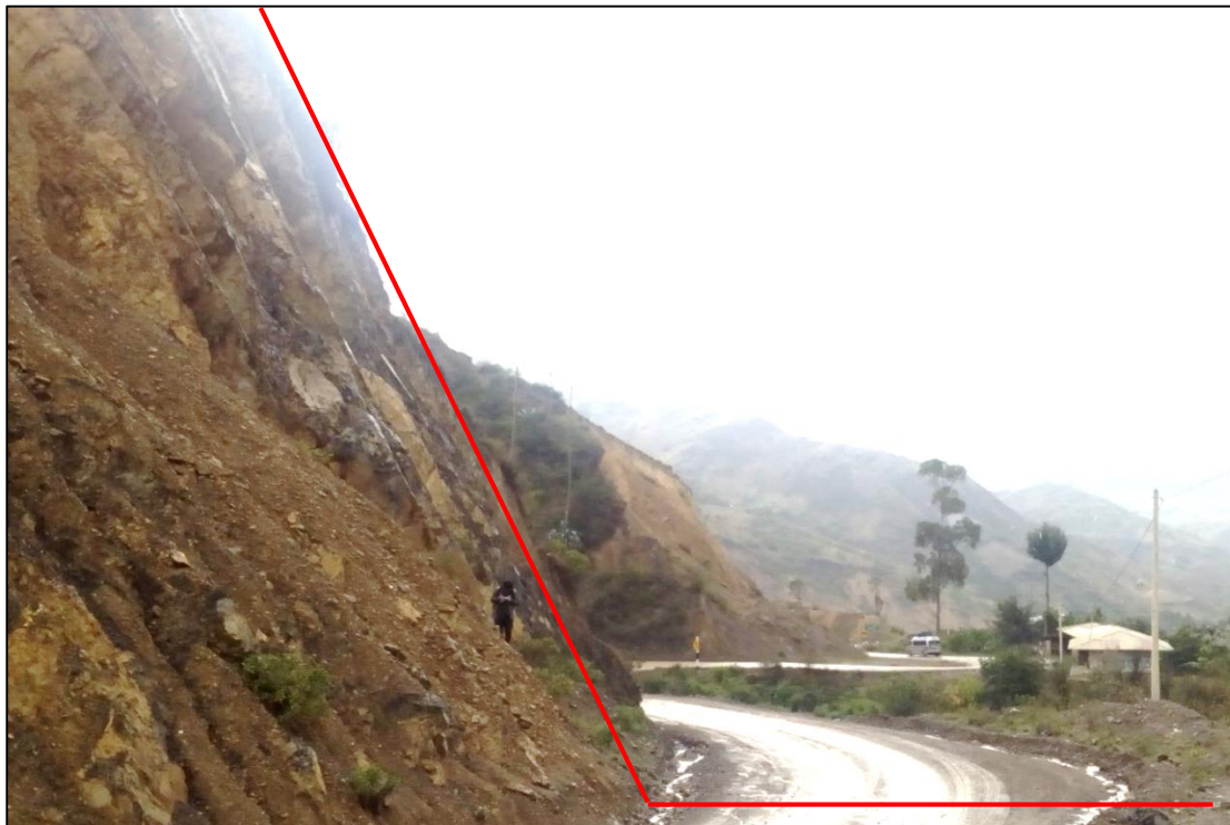
Foto 3.36: Perfil del talud en la progresiva Km 134+875.
