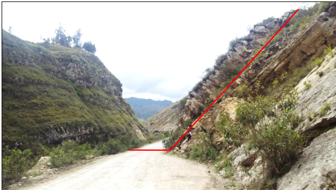
Foto 3.26: Perfil del talud en la progresiva Km 140+744.
