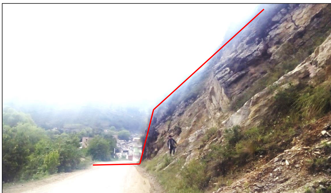
Foto 3.22: Perfil del talud en la progresiva Km 141+575.
