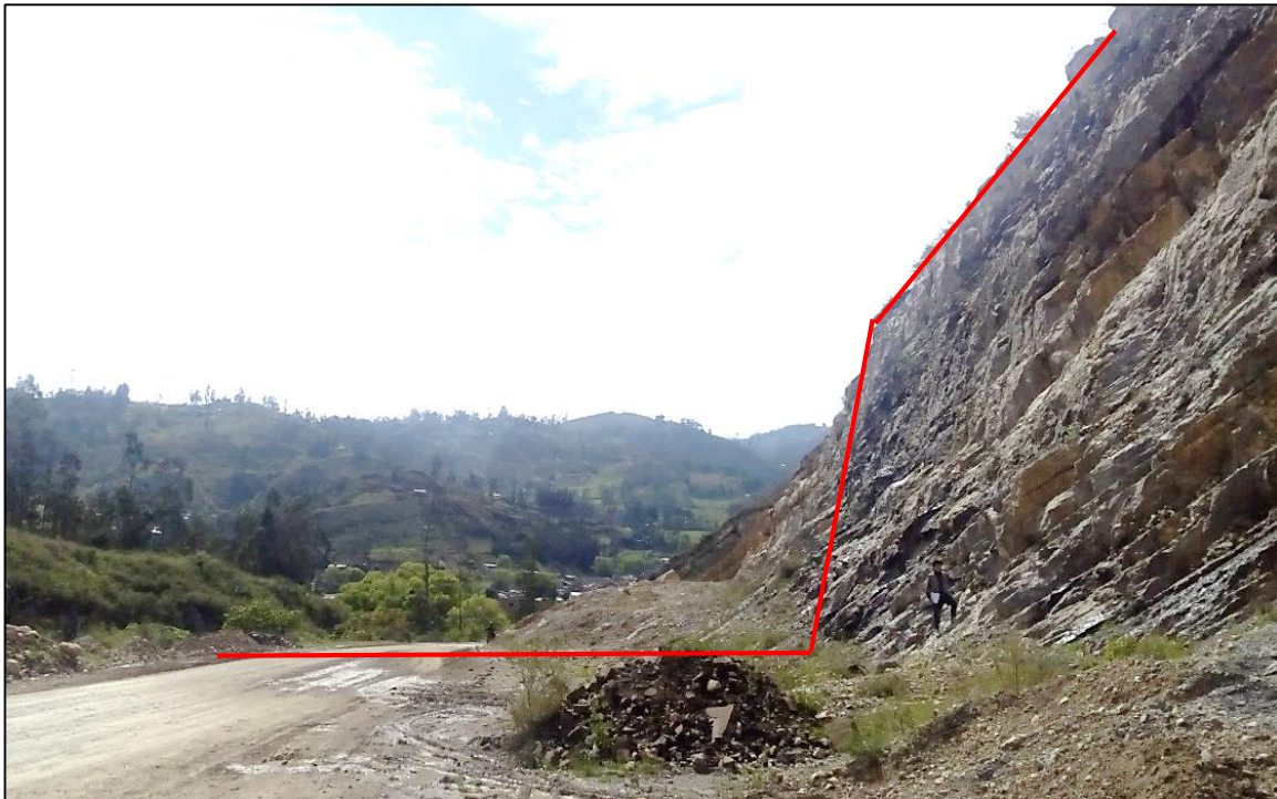
Foto 3.24: Perfil del talud en la progresiva Km 141+424.
