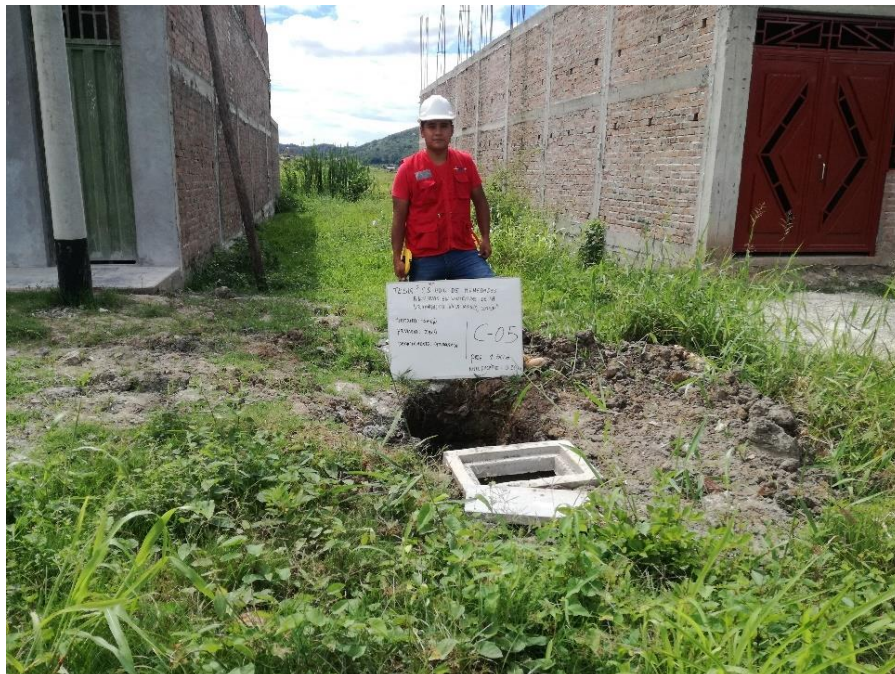
Foto 24: Vista de la calicata C-05.
