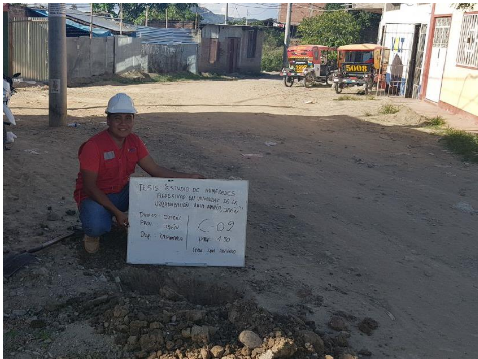
Foto 21: Vista de la calicata C-02.
