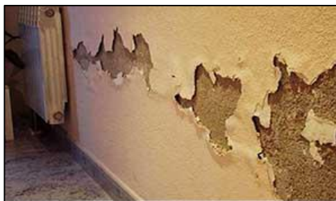
Figura 2.6 Criptoflorescencias (disponible en: http://www.aloservicios.cl/consejos-filtraciones.html )
