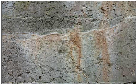
Figura 2.9 Agresión química por lixiviación (disponible en: https://es.123rf.com )
