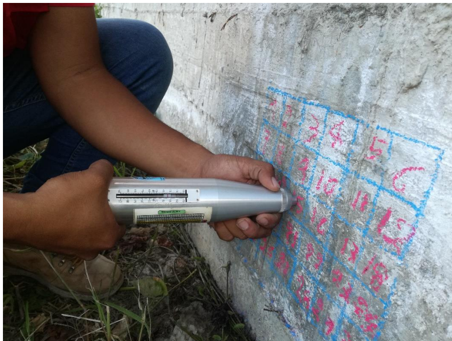
Foto 26: Ensayo de compresión del concreto endurecido con esclerómetro
