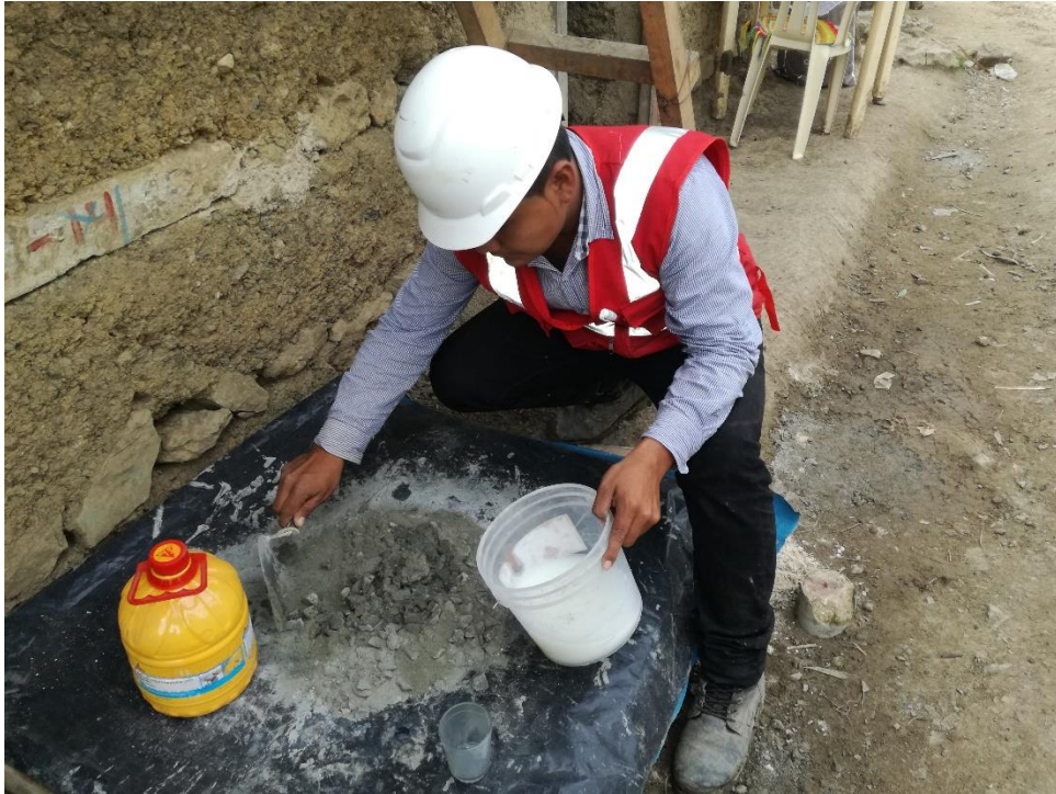
Foto 39: Concreto con impermeabilizante para la elaboración de especímenes.
