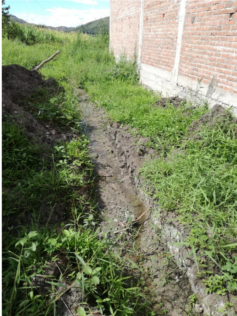
Foto 13: Excavación de zanja provisional para evacuar el agua de napa freática.
