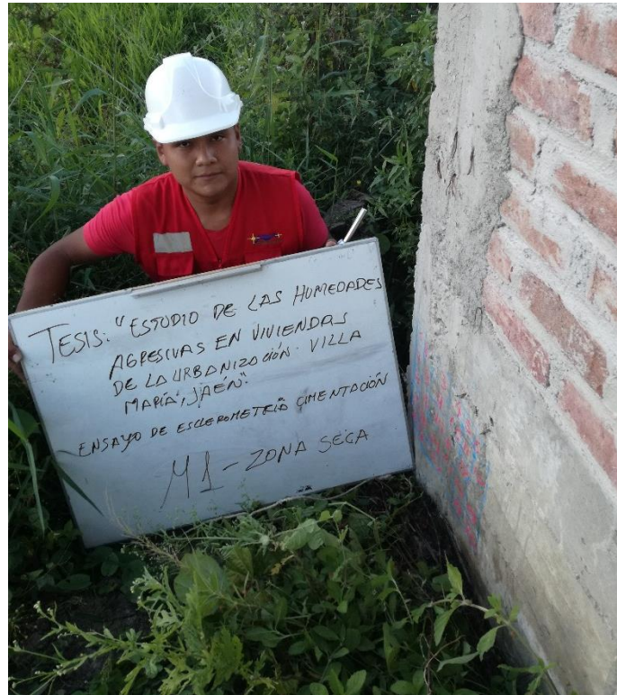
Foto 27: Vista de la muestra 01 en estado seco para ensayo de esclerometría.
