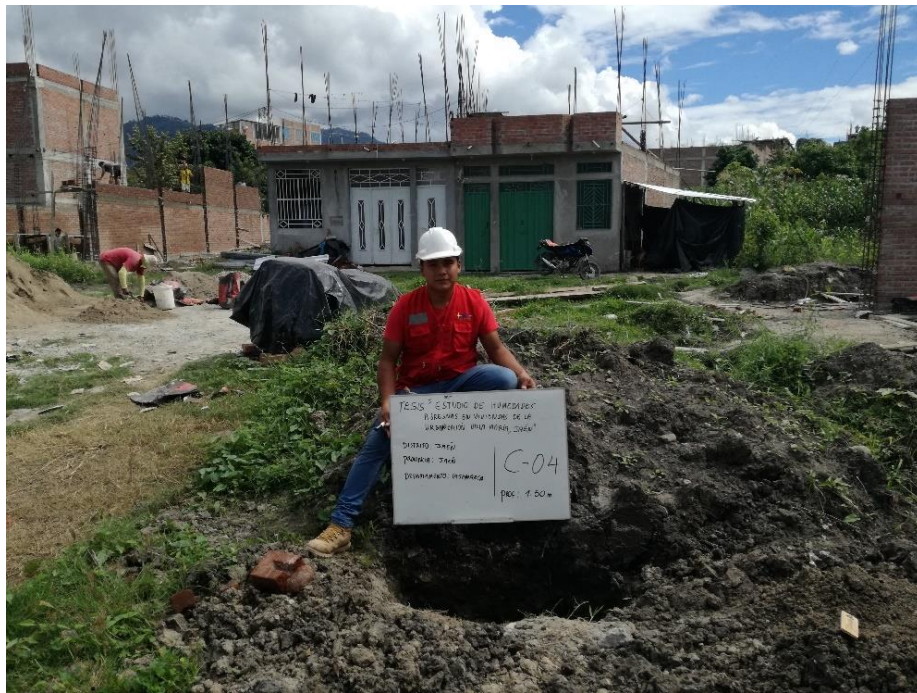
Foto 23: Vista de la calicata C-04.
