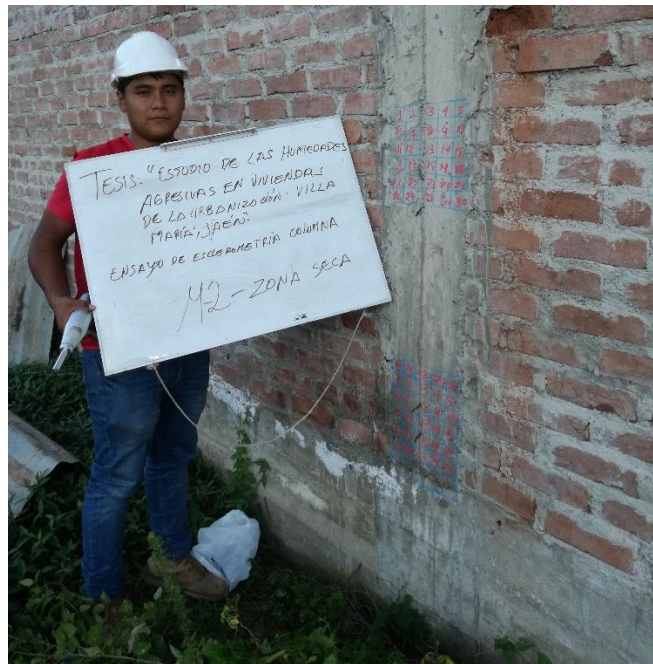
Foto 29: Vista de la muestra 02 para ensayo de resistencia del concreto.
