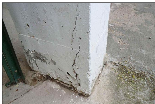
Figura 2.10 Fisuras en concreto (disponible: https://www.rtarquitectura.com/tipos-de-fisuras-y-grietas-en-el-hormigon/ )
