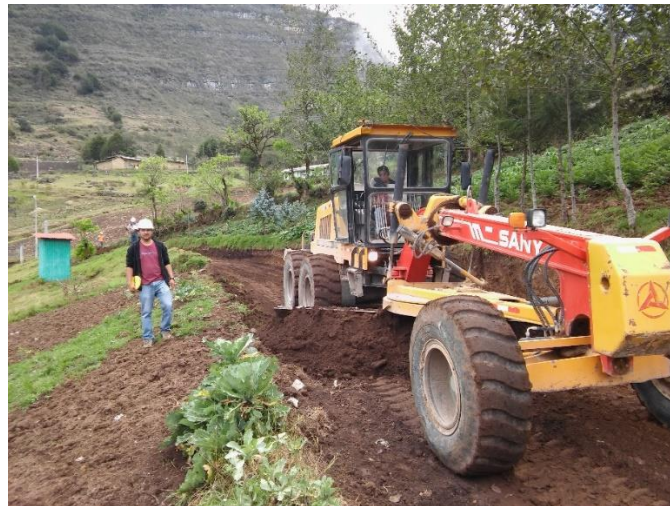
Figura 3: Trabajos de ensanche en carretera.
