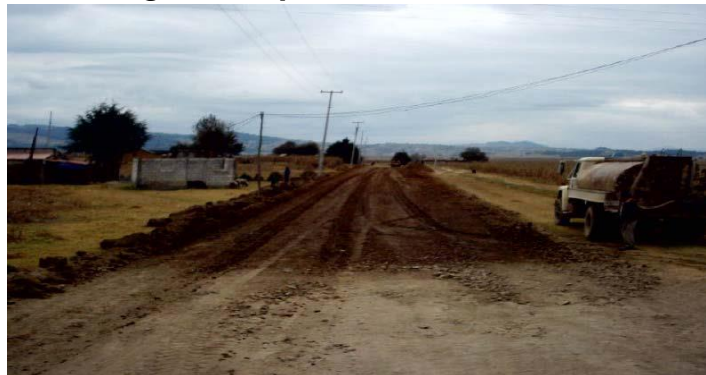
Figura 9: Aplicación de salmuera en campo
