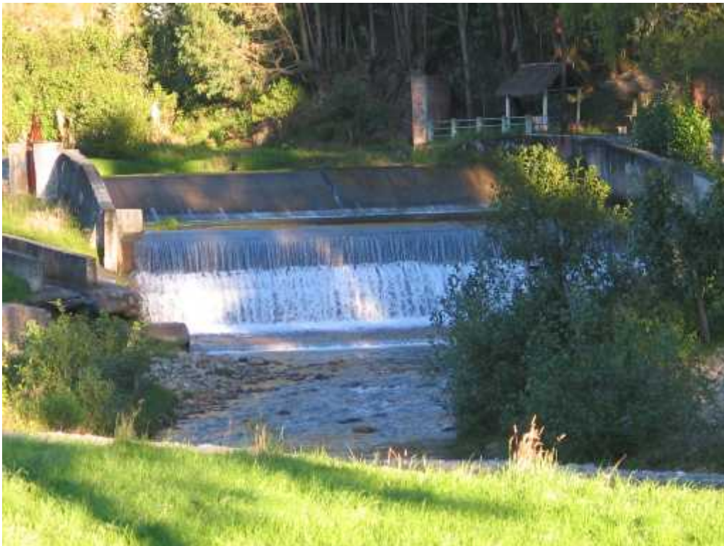
Foto 5. Río Grande, antes de la derivación hacia la Planta el Milagro
