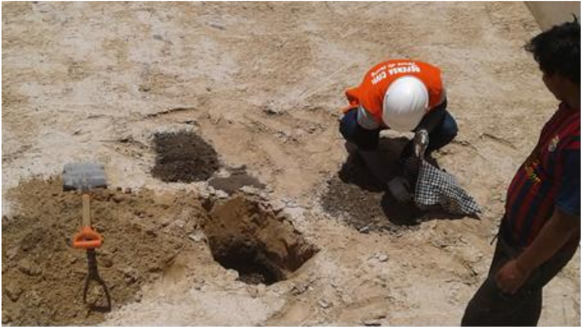
Figura 36. Extracción de arena y grava lecho filtrante del FLA
