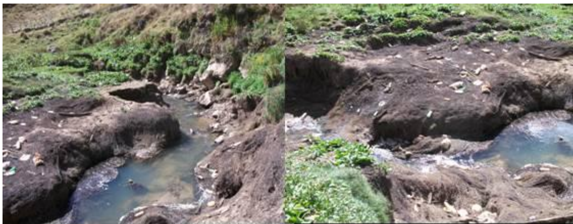
Figura 6. Vista del sumidero ubicado zona de Tincat
