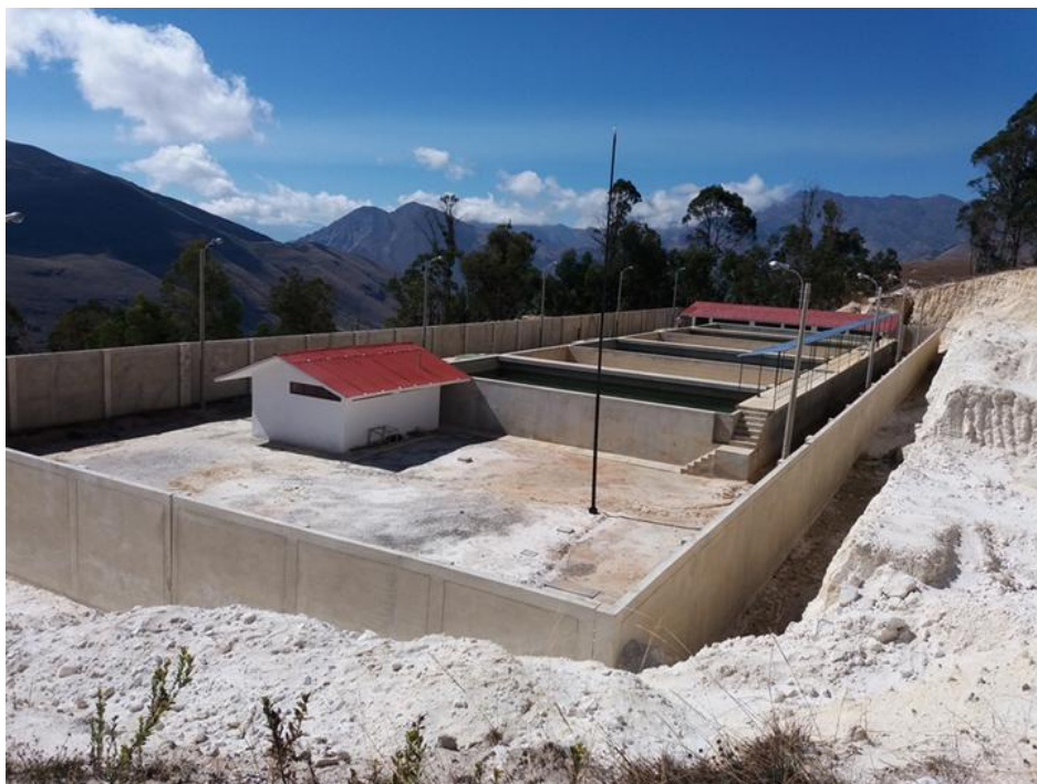
Figura 15. Vista de la PTAP La Quesera
