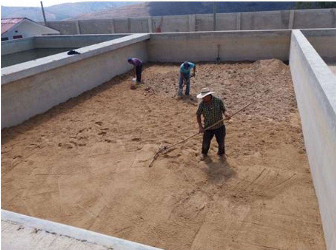
Figura 35. Reposición de capa de arena en FLA de la PTAP La Quesera
