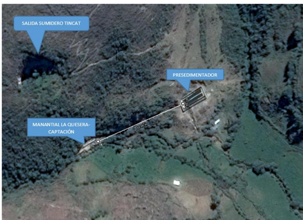
Figura 3. Vista de salida sumidero, captación y presedimentador Fuente: Google Earth Pro. 2017
