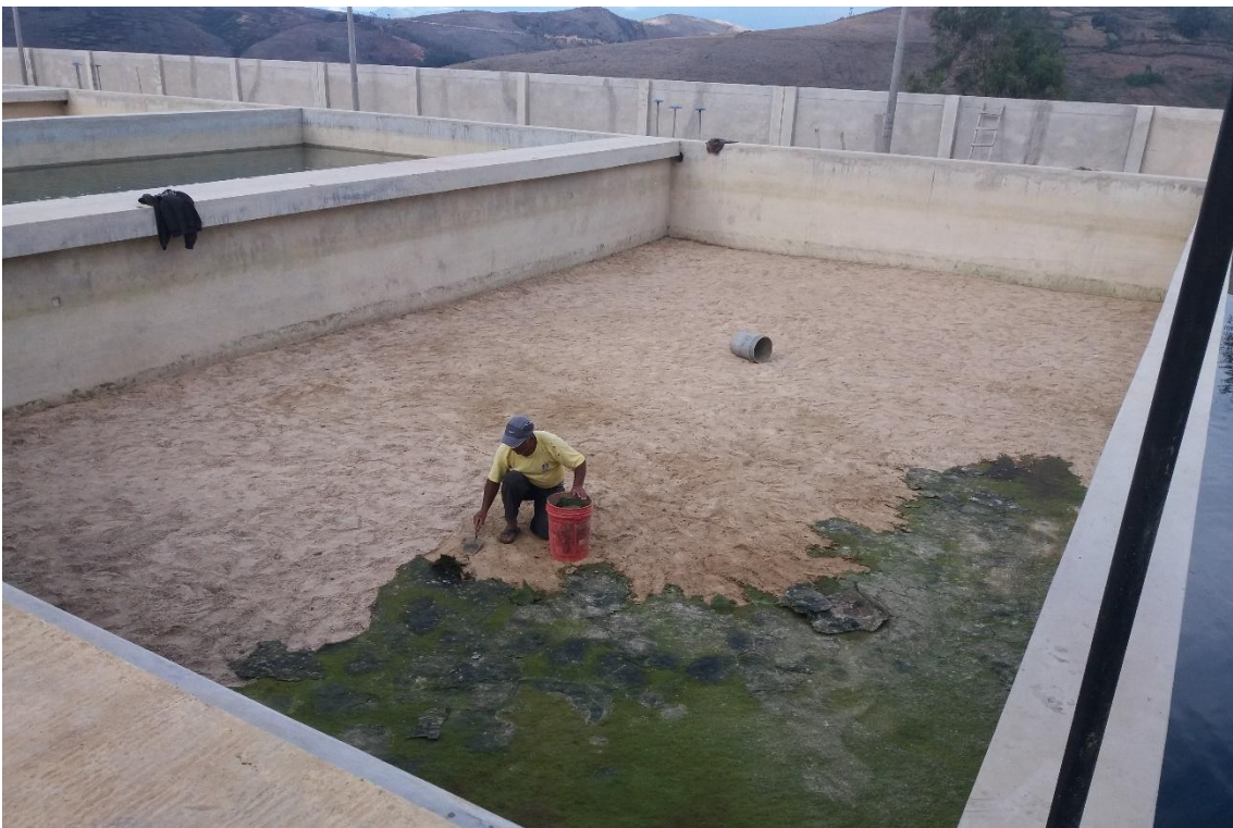
Figura 33. Raspado del biofilm PTAP La Quesera
