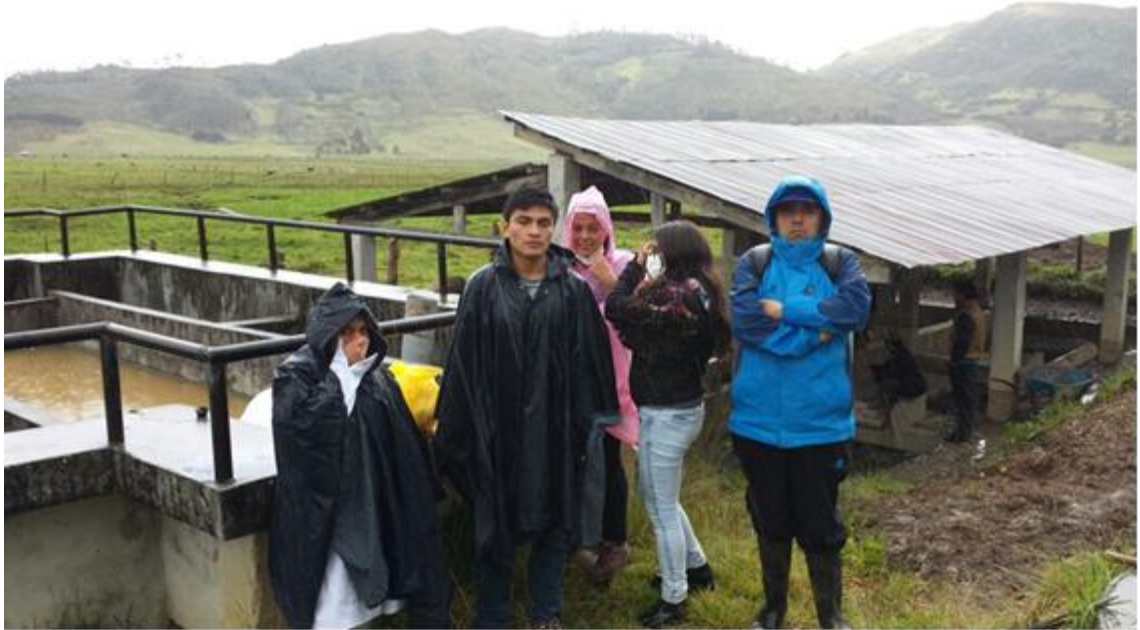
Figura 26. PTAR Caserío Tincat-Sucre
