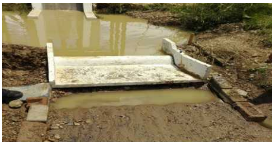
Figura 46. Socavación en modelo físico de campo.
