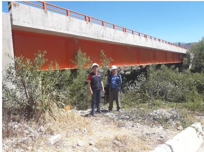
Fotografía 06: Elementos estructurales, vigas y losas, del puente Chotano
