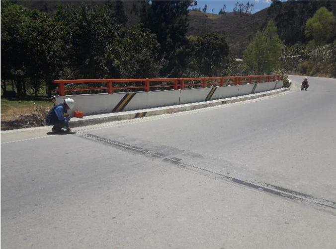
Fotografía 17: Tesista realizando ensayos de Esclerometría
