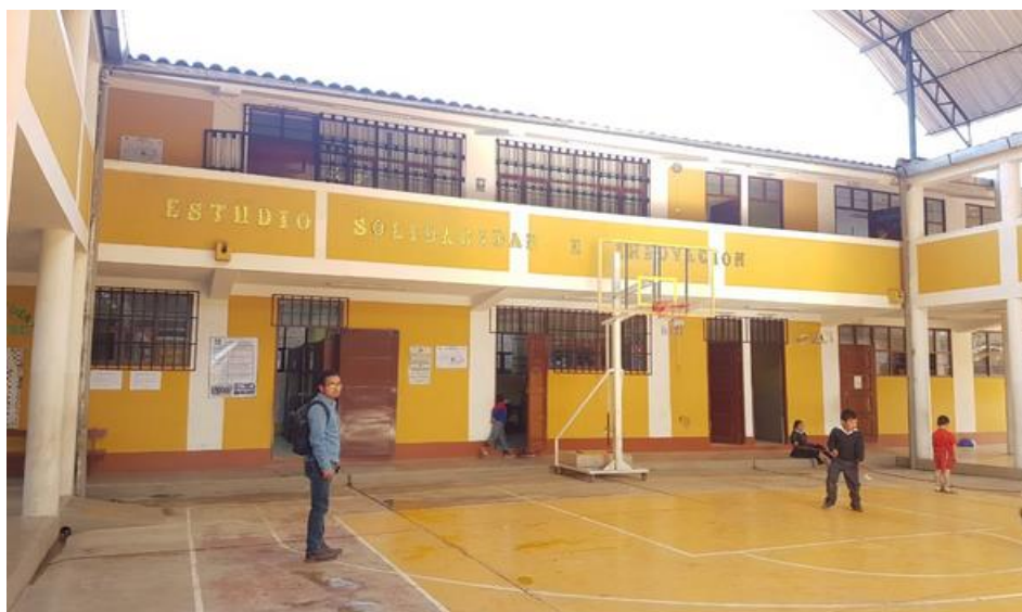
Figura 3.5: Módulo C de la I.E. N° 82954 Pachacútec
