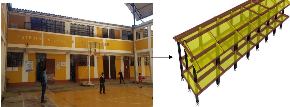
Figura 3.24: Estructura del módulo C de la I.E. N°82594 Pachacútec
