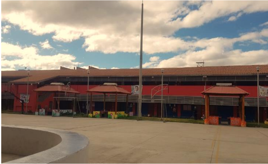
Figura 3.7: Fachada principal de la I.E. N° 82016 Santa Teresita- Primaria
