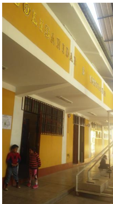
Figura 3.6: Vista lateral del módulo C de la I.E. N° 82954 Pachacútec
