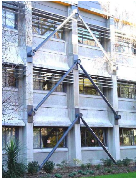
Figura 4: Ejemplo de rehabilitación mediante la inclusión de arriostres de acero a una estructura de concreto armado. (Crisafulli 2014: 45)
