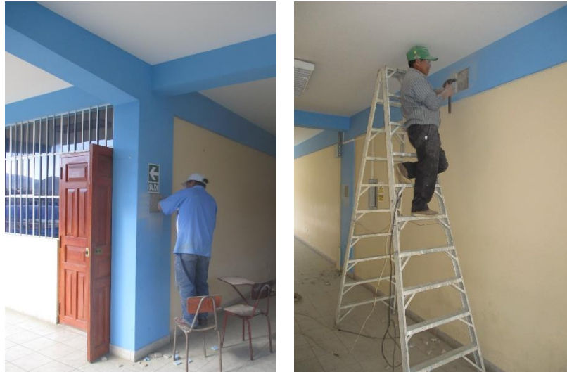
Fotografía 1: Retirando el tarrajeo de los elementos estructurales, para realizar ensayos de esclerometría.
