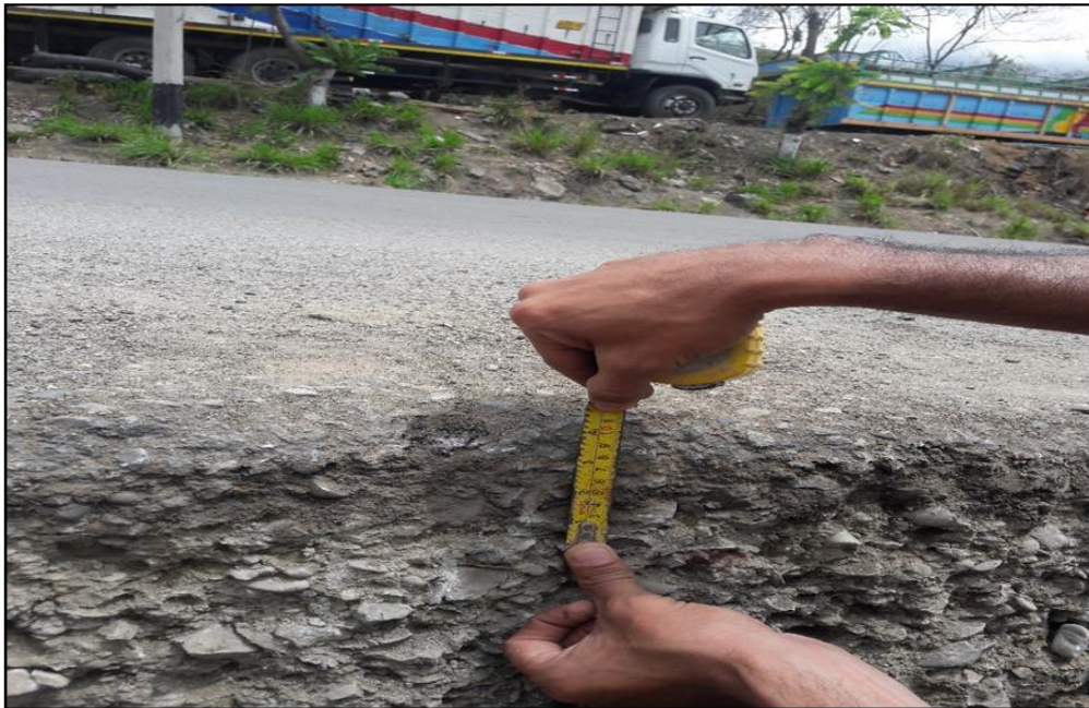
MEDIDA DE LA CARPETA ASFALTICA (0.10 m)
