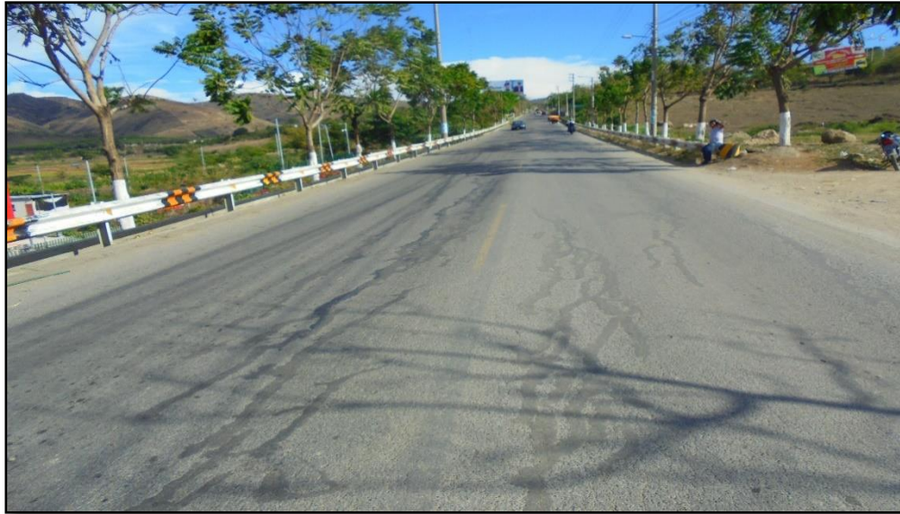
Figura 2 : Grietas longitudinales
