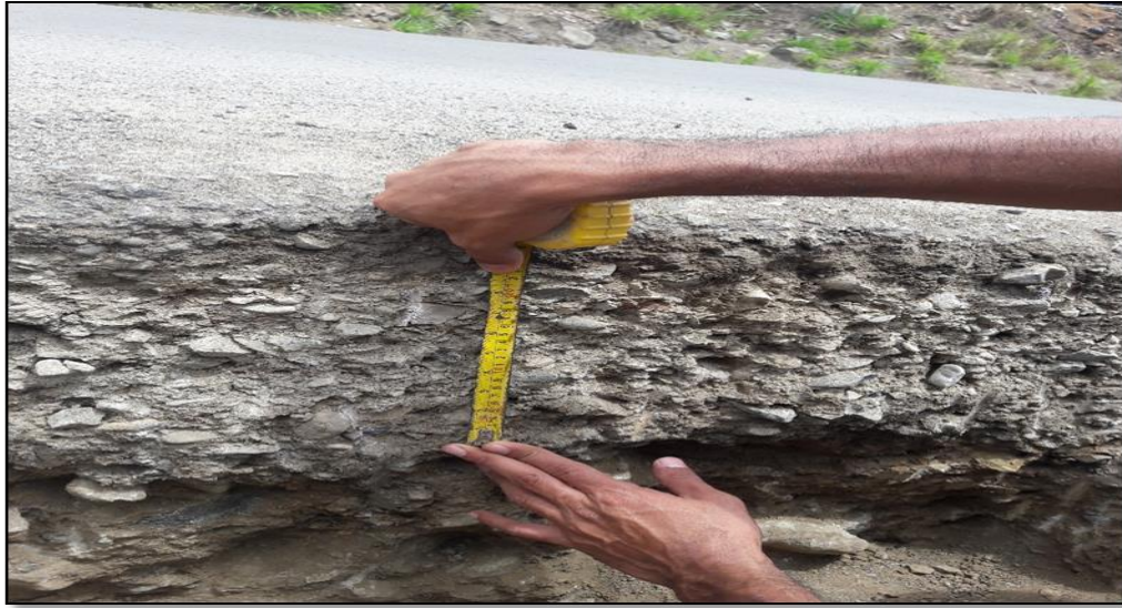
MEDIDA DE LA CARPETA ASFALTICA (0.10 m)
