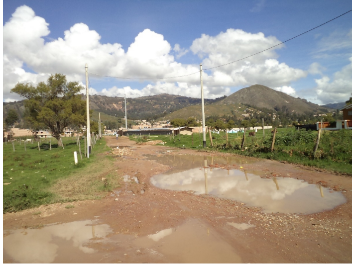
Figura 56. Estado de la avenida Dinamarca durante la temporada de lluvias
