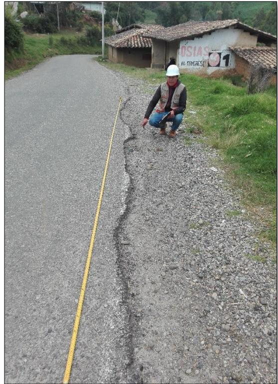
Fotografía 14: Desintegración de los bordes del pavimento.
