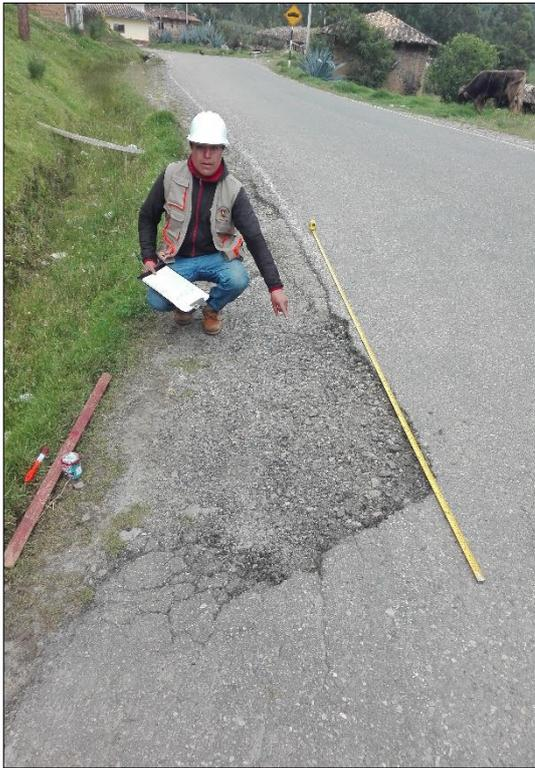
Fotografía 13: Desintegración de los bordes del pavimento.
