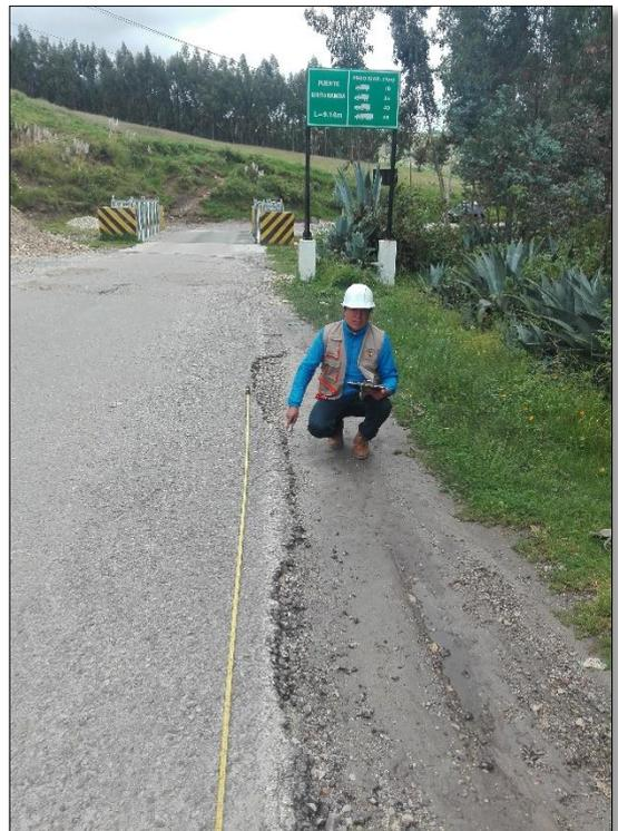
Fotografía 108: Desintegración de los bordes del pavimento.
