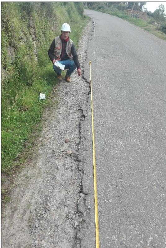
Fotografía 15: Desintegración de los bordes del pavimento.
