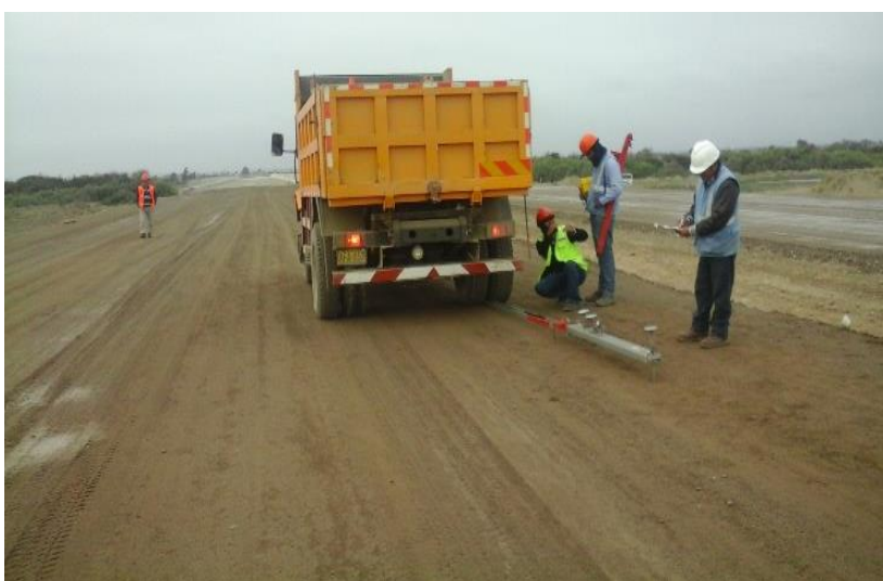
Figura N°22. Ensayo de deflectometría sobre la subrasante terminada
