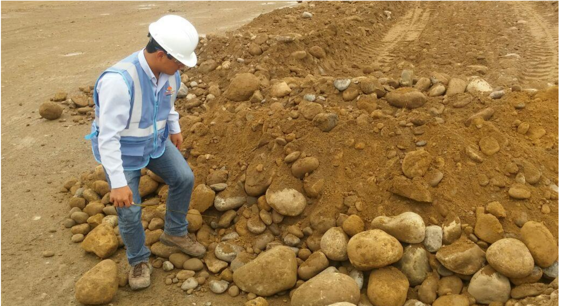
Figura N°19: Inspección del material que supera los límites admisibles de la especificación técnica, progresiva km.60+000.
