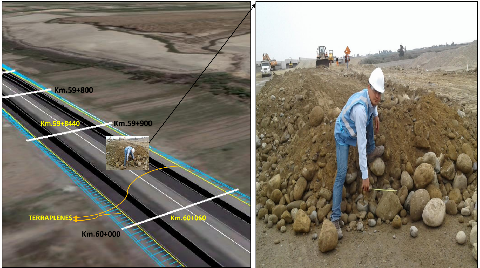
Figura N°18: Conformación de material en la corona del terraplén, progresiva km.59+900.
