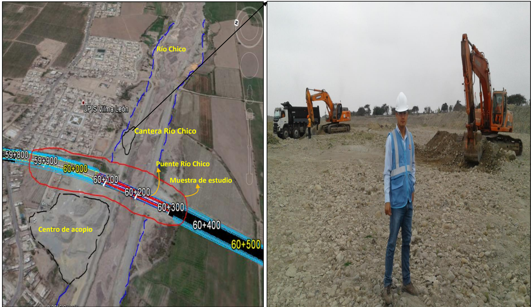
Figura N°20: Extracción de material sin la utilización de zarandas a fin de seleccionar el material (Cantera Río Chico)
