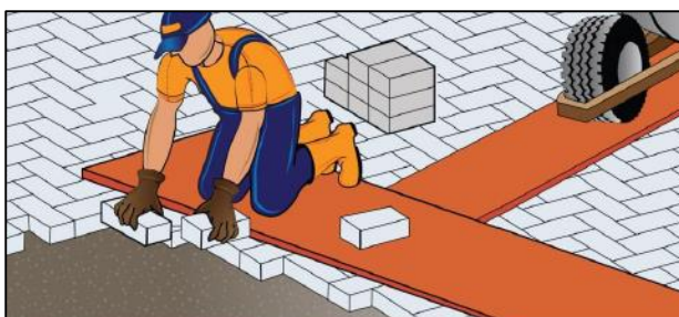
Figura N° 20: Colocación de adoquines.
