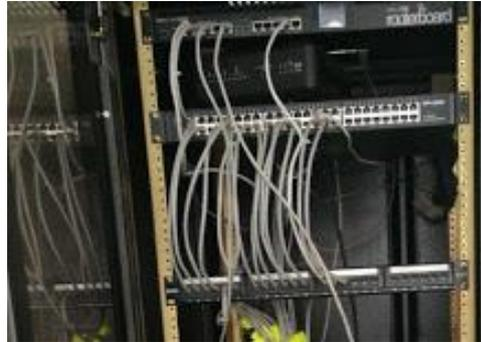
*Fig. 25: Switch que muestra todas las salidas de la red Cableada*
