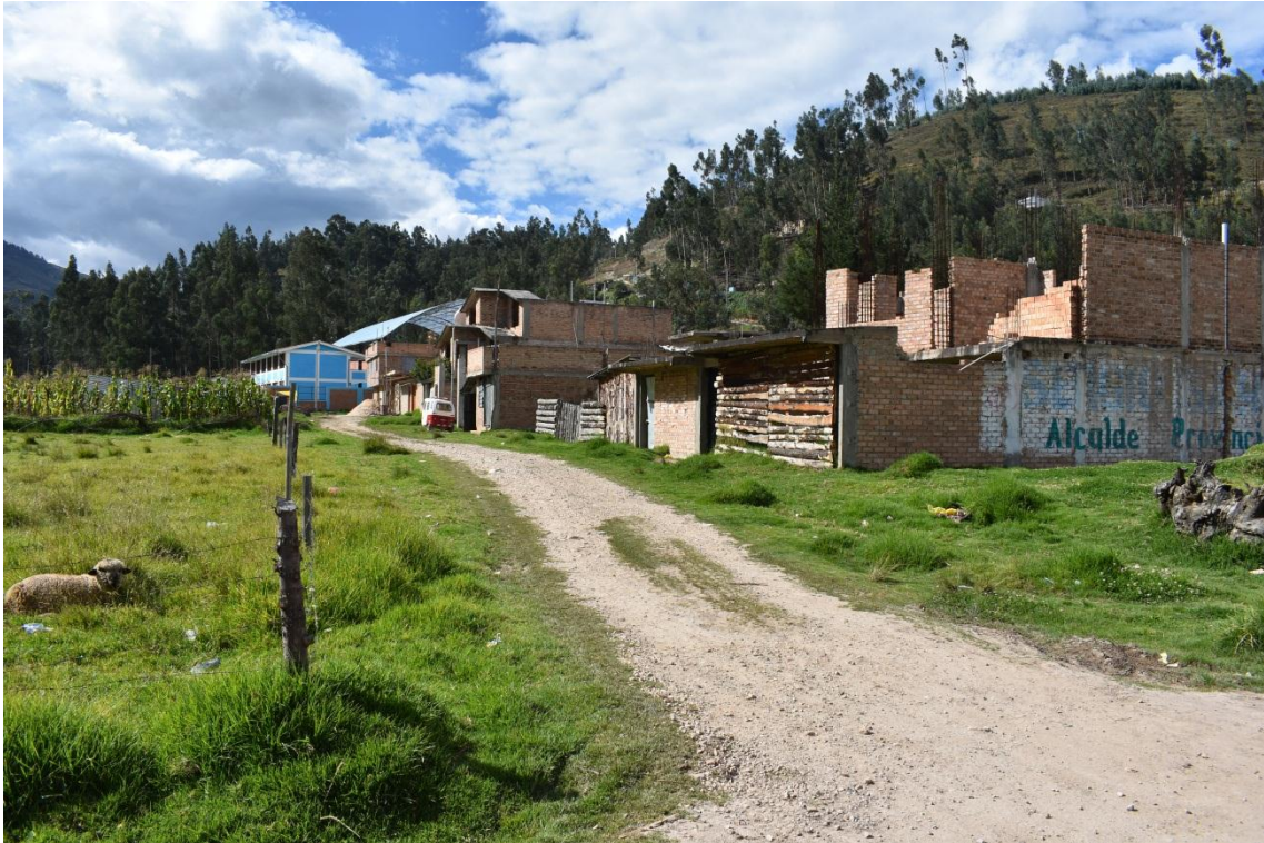
Figura 57. Calles y viviendas aledañas a la quebrada Sambarbamba.
