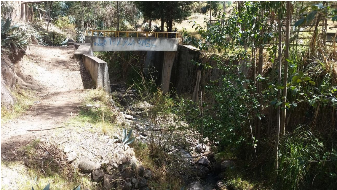
Figura 76. Primer puente ubicado en el cauce de la quebrada Sambarbamba.
