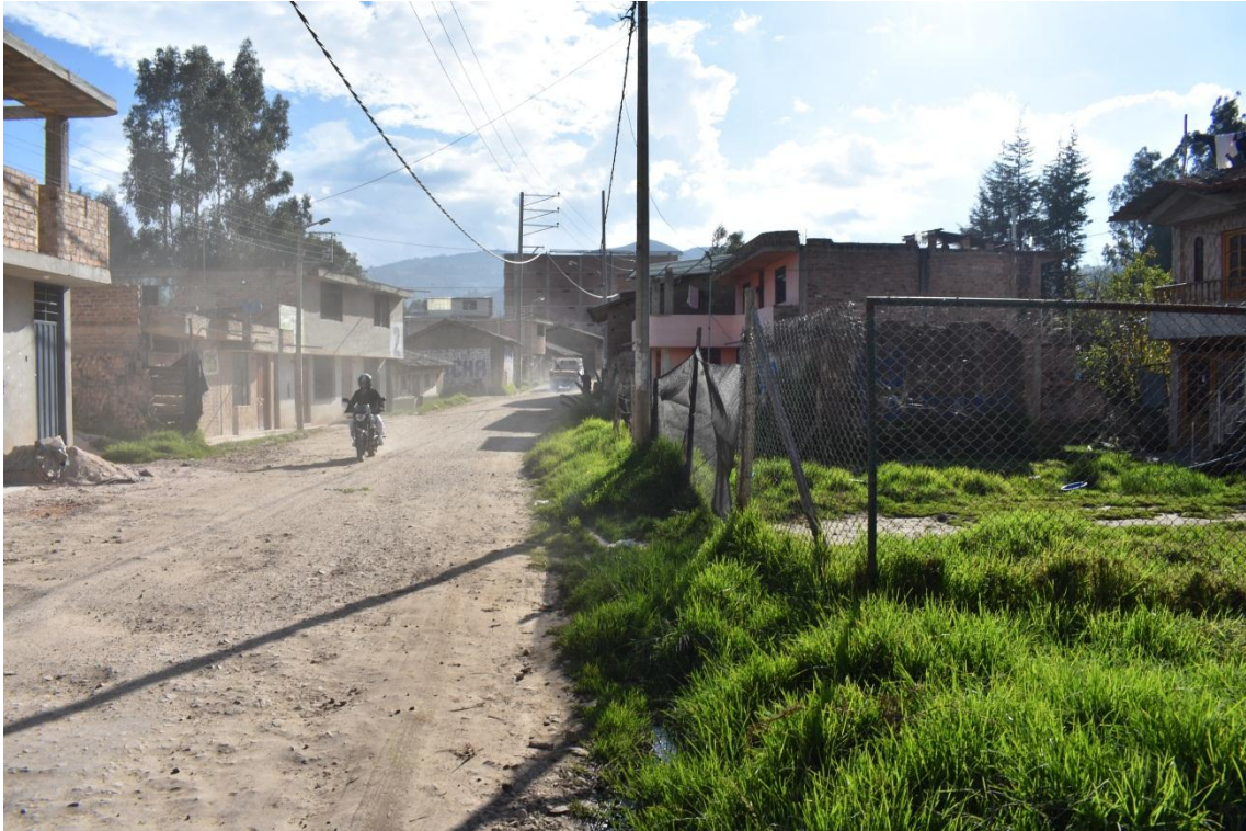
Figura 75. Viviendas y calles de la localidad de Santa Bárbara.
