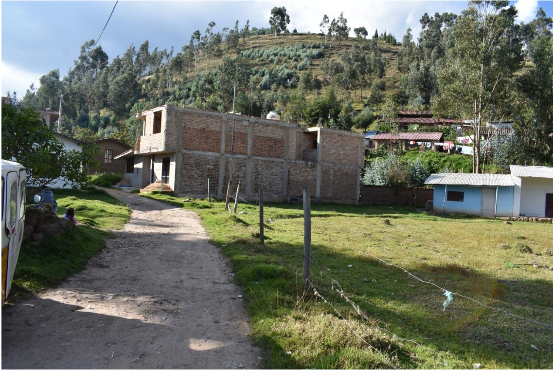
Figura 73. Viviendas y calles de la localidad de Santa Bárbara.
