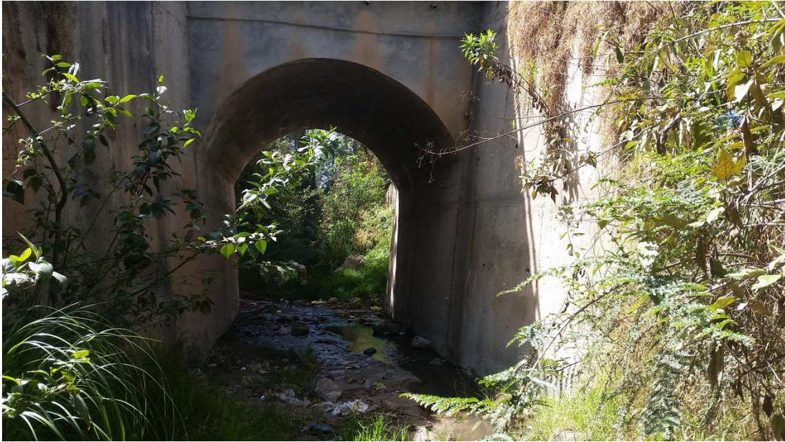
Figura 77. Segundo puente ubicado en el cauce de la quebrada Sambarbamba.
