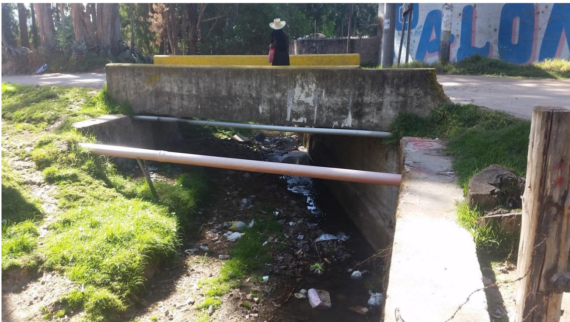
Figura 78. Tercer puente ubicado en el cauce de la quebrada Sambarbamba.
