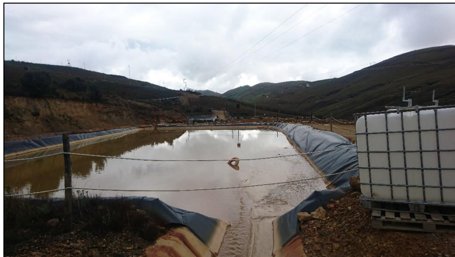
Figura 62: vista de la colmatación de la poza de sedimentación.
