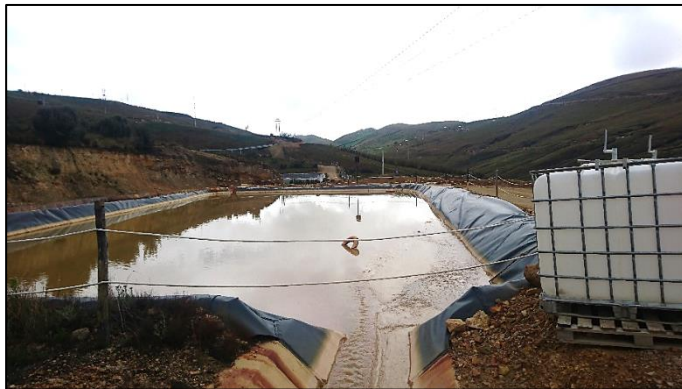
Figura 29: Vista de la primera poza de sedimentación (600 m 3 ) llena de sedimento
