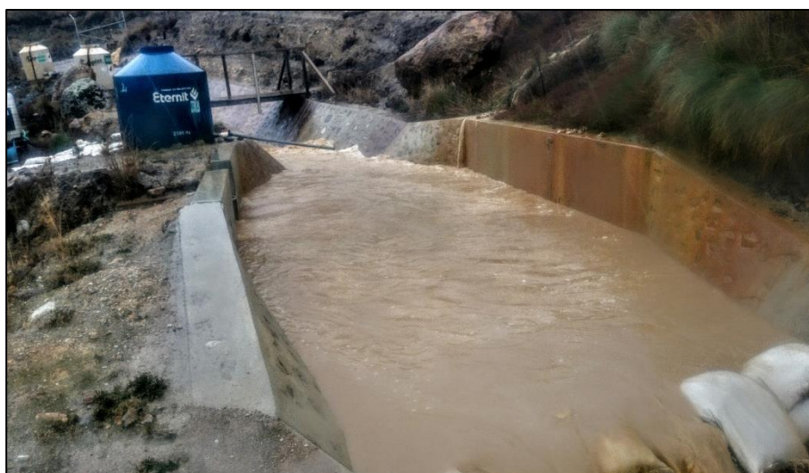
Figura 60: agua de escorrentía en el desarenador.
