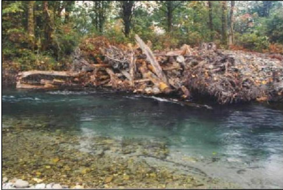
Figura 19: Deflexión del flujo de un ELJ y ejemplo de una estructura tal como está que protege la orilla izquierda (mirando hacia abajo) y creando piscina y cobertura compleja para peces en North Fork Stillaguamish River, Snohomish County, Washington (flujo de izquierda a derecha).
