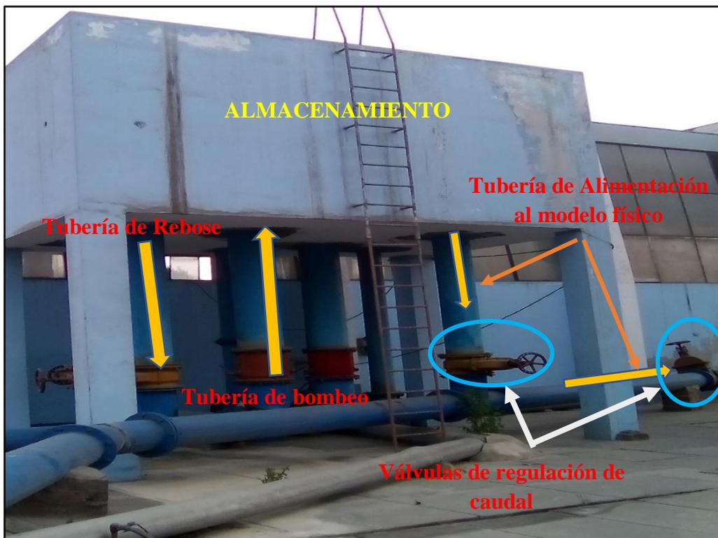
Figura 73: Vista panorámica del tanque elevado, tuberías de alimentación y rebose y válvulas tipo compuerta instaladas en la tubería de alimentación al modelo físico
