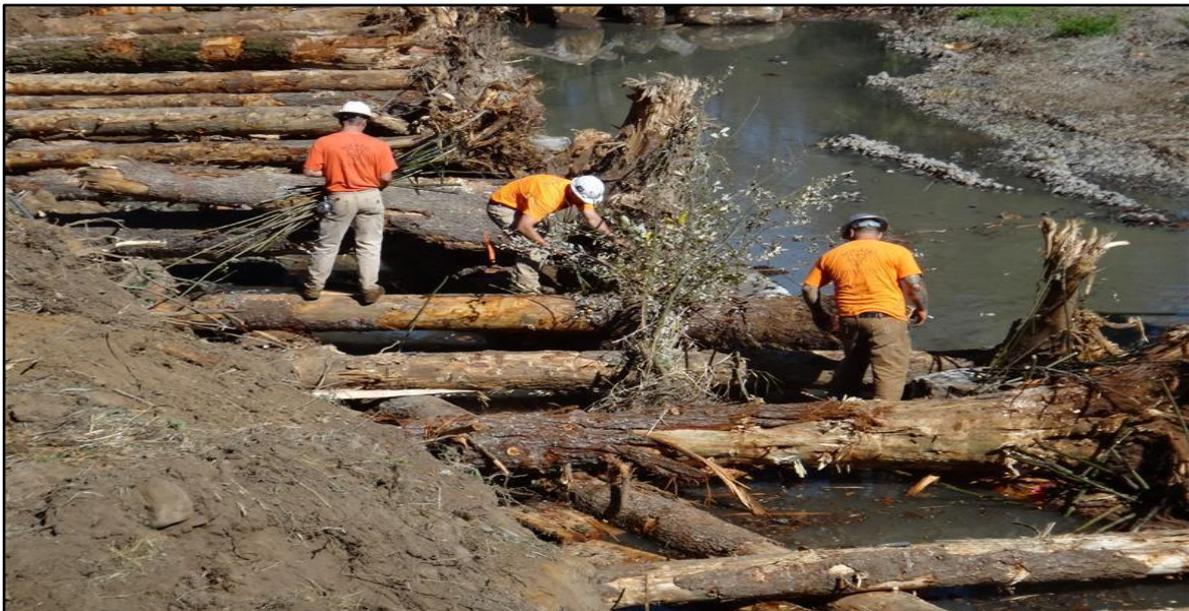
Figura 20: Colocación de estacas de sauce en un sistema de ELJs proyectados en el río Lower Molalla, en Oregón – Washington
