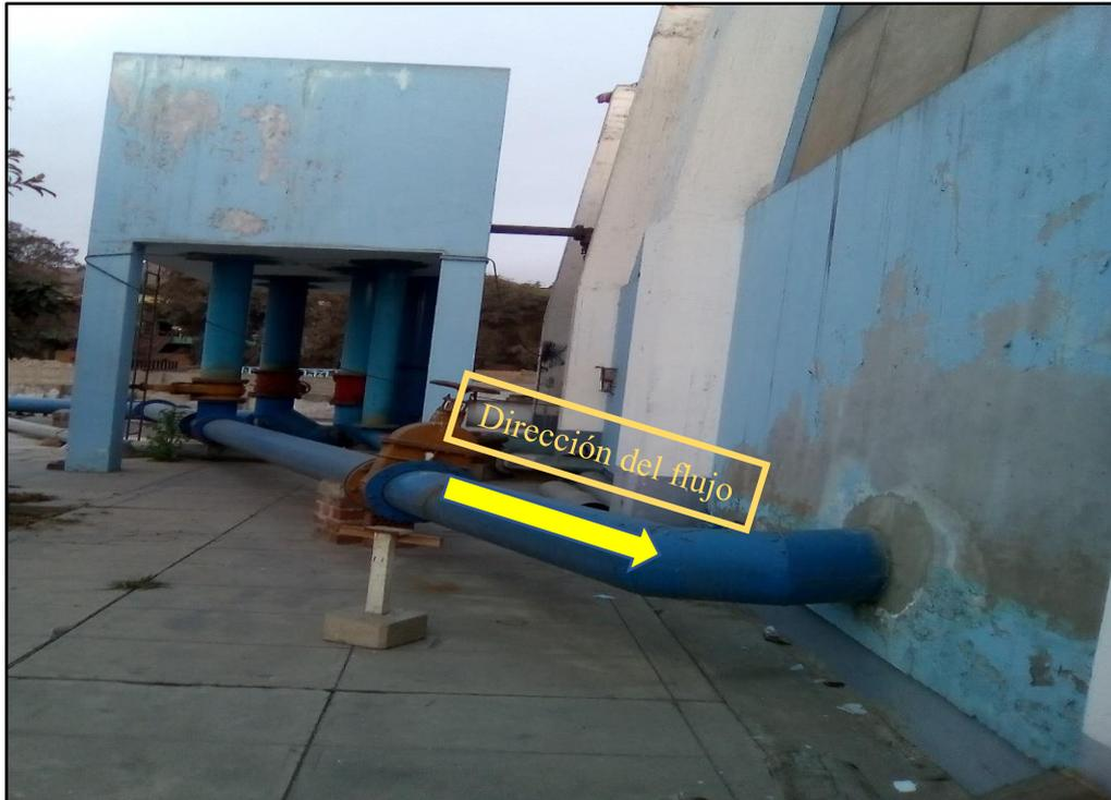
Figura 74: Vista panorámica de la tubería de alimentación de caudal al modelo experimental
