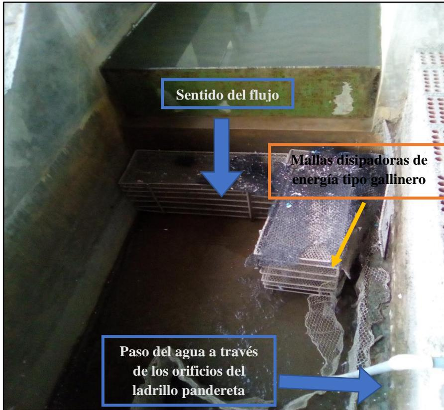
Figura 76: Disipadores de energía de malla tipo gallinero
