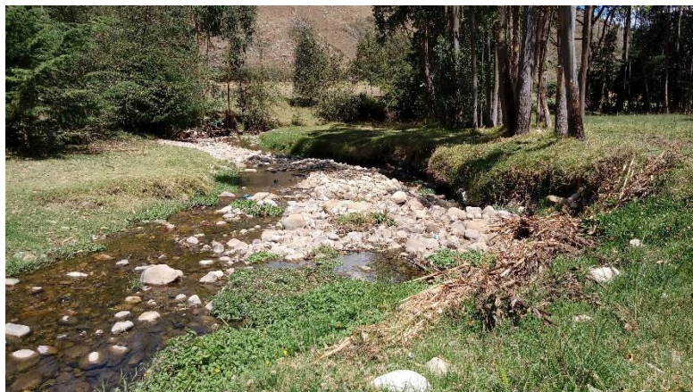
Figura 43. Socavación del tramo del río en estudio
