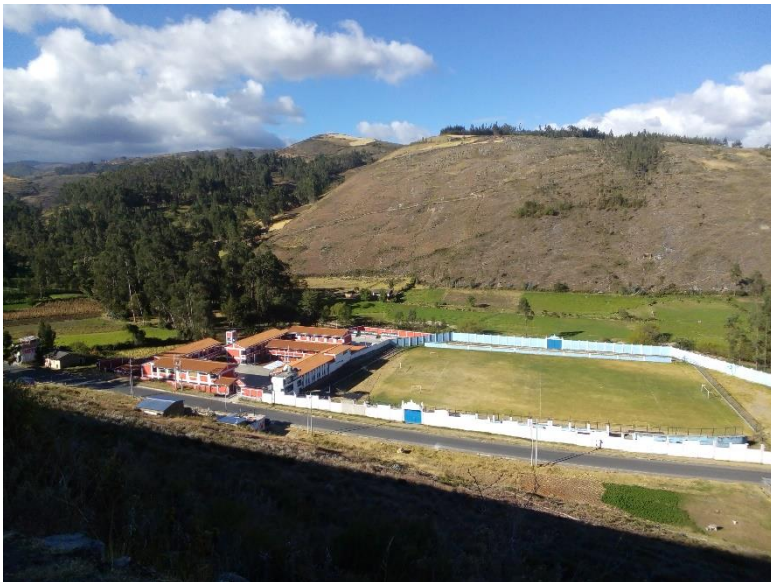
Figura 31. Vista del tramo de estudio con áreas de Pastos, vegetación ligera y a la parte del fondo sin vegetación.
