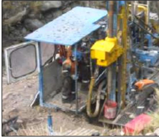
Foto 4. Máquina perforadora realizando el taladro BH-04-18
