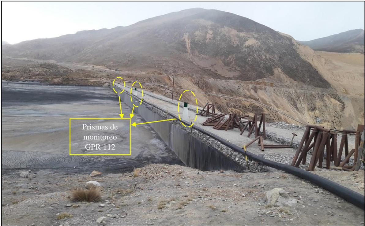
Foto 11. Prismas de monitoreo instalados para registrar movimientos superficiales en la presa de relaves
