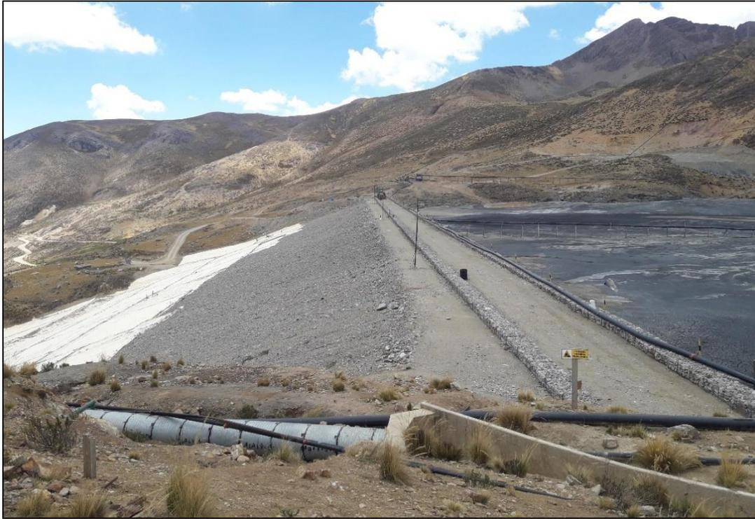
Foto 2. Dique de contención de la presa de relaves – U.M. Yauricocha
