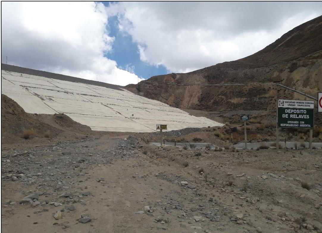
Foto 3. Talud de la presa de relaves, ángulo 45°– U.M. Yauricocha
