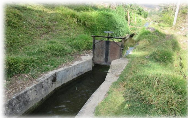
Figura 5. Aforamiento del canal de regadío
