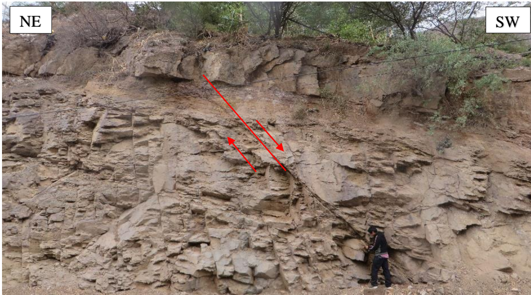
Figura 3.11. Falla normal, con orientación: Az = 205°, Bz = 40°NW, ubicado en el flanco izquierdo de la carreteta, perteneciente al volcánico Chilete moderadamente meteorizado y alto fracturamiento del macizo rocoso.
