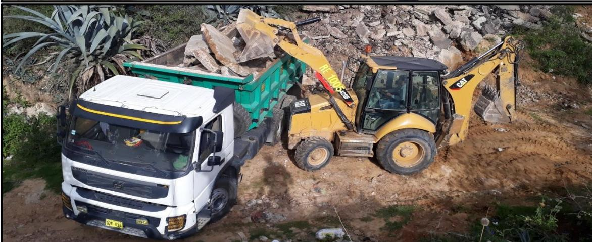
Figura 46: Carguío de los bloques de concreto reciclado al volquete
