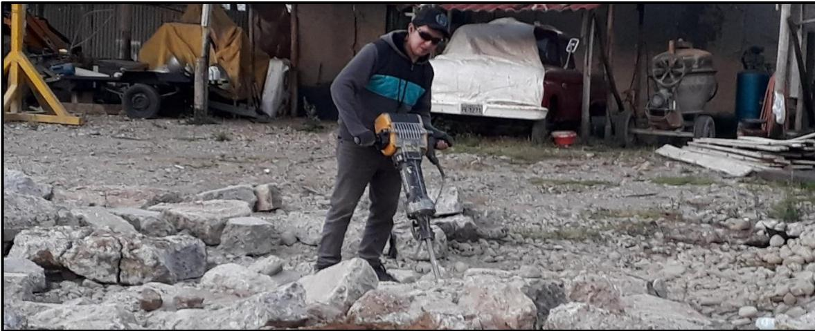
**Figura 48: Rotura de bloques de concreto reciclado en bloques más pequeños**
