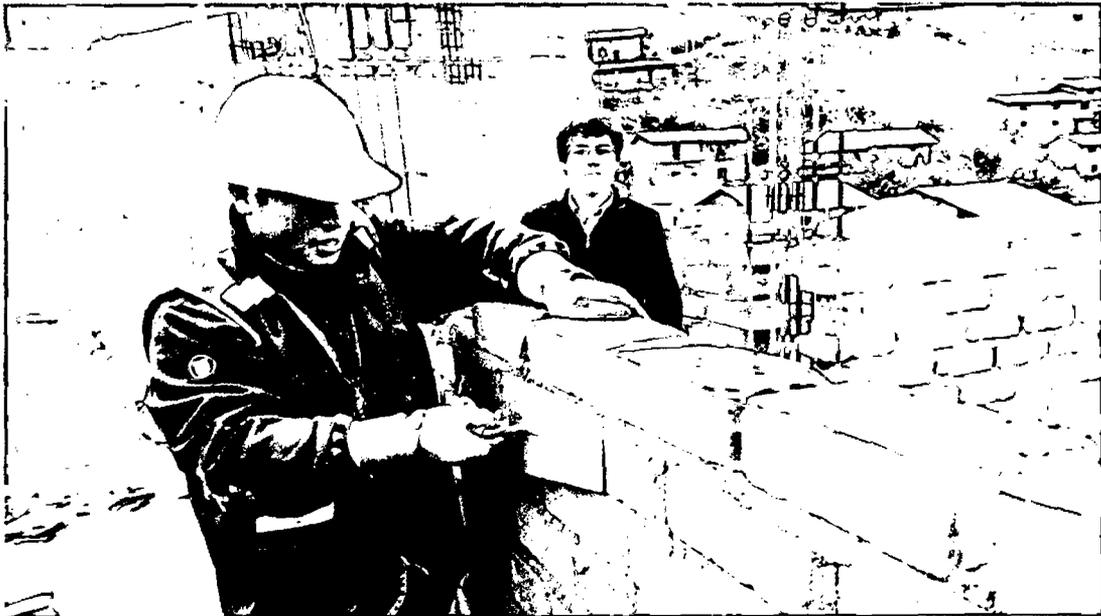
FOTO N° 04: Asentado de ladrillo segundo nivel.
