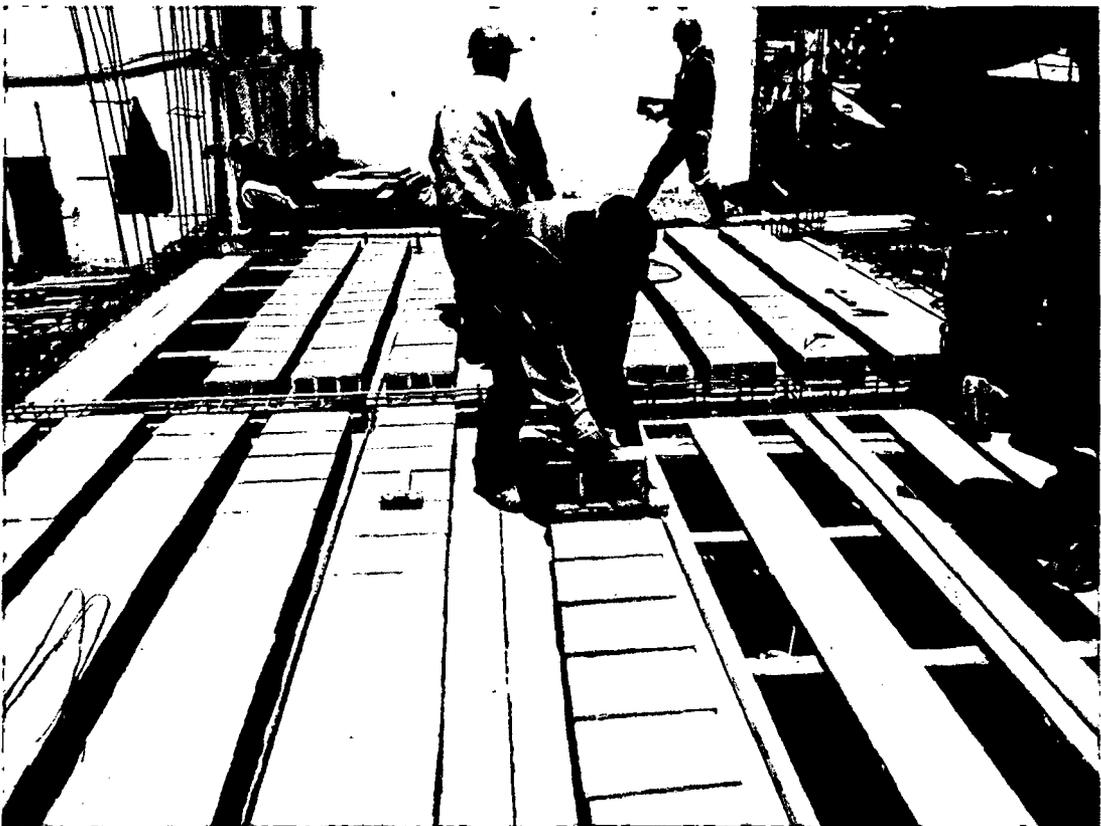
FOTO N° 06: Colocación de ladrillo para losa aligerada.
