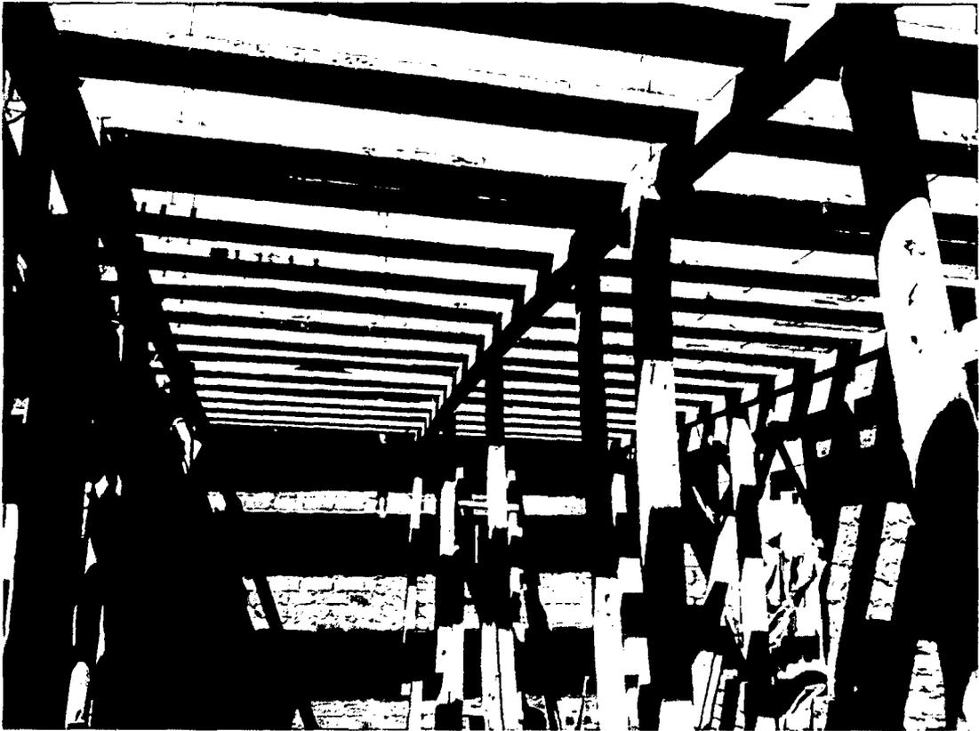
FOTO N° 05: Encofrado de losa aligerada.
