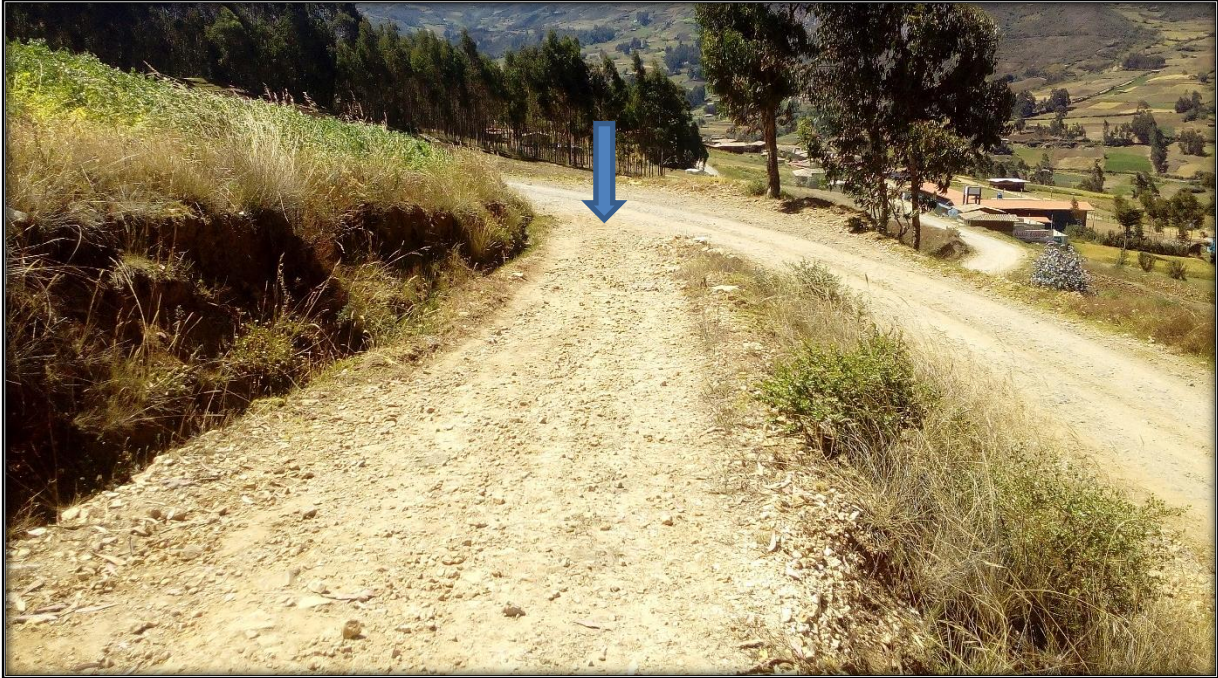
Foto A.3. Punto inicial del tramo de la carretera km 00 + 000.00 en el sector la Shita.
