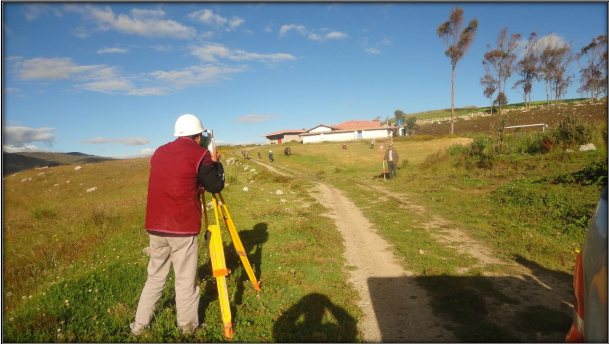
Foto A.8. Toma de puntos con estación total, lugar Atumpata.
