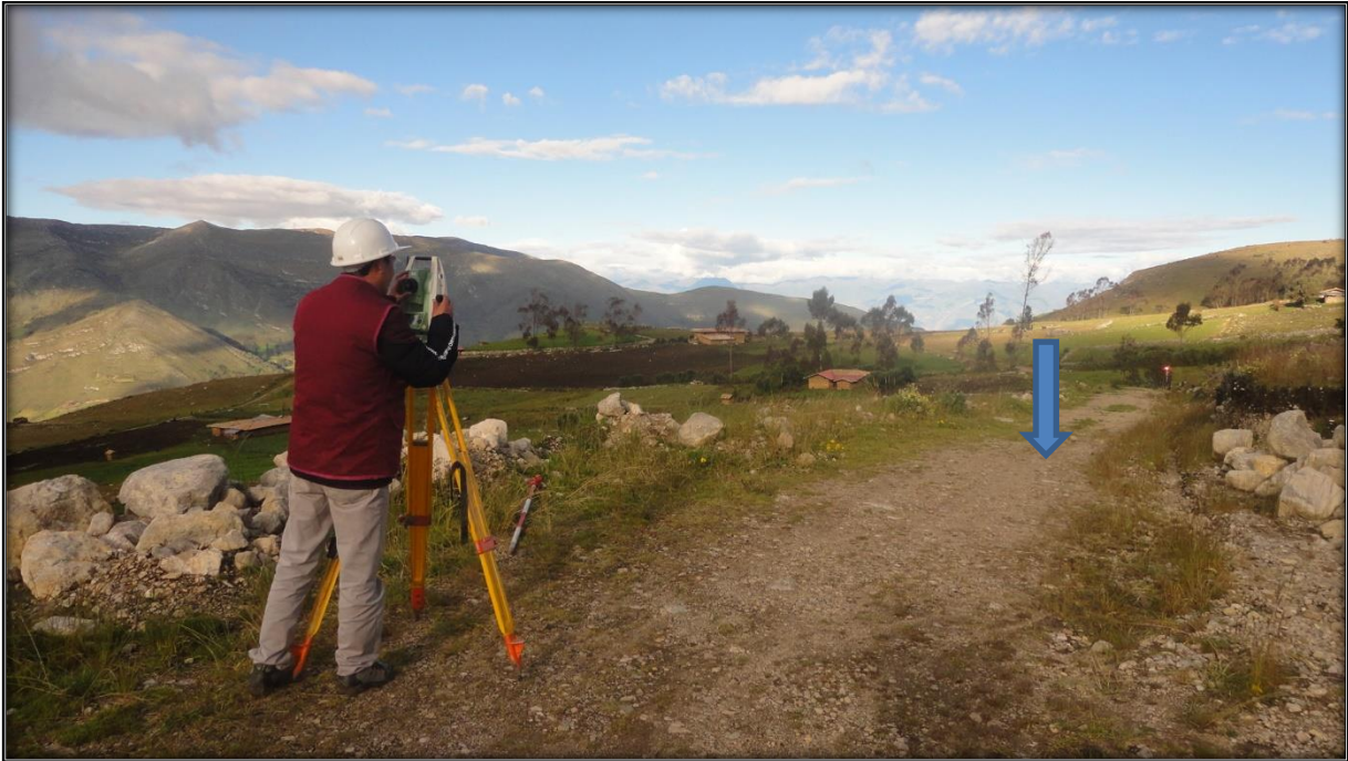
Foto A.12. Punto final hasta donde se ha realizado la presente tesis en el km 00 + 000.00 en el Caserío Atumpata.
