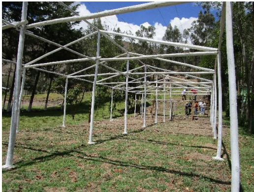
Figura 24. Construcción de invernaderos con material de madera y plástico polietileno.
