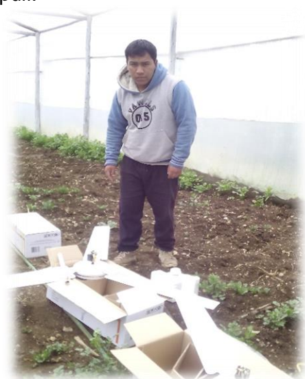
Figura 28. Instalación de ventiladores.
