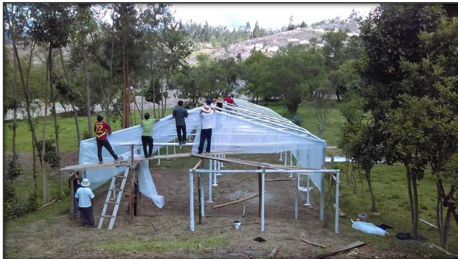
Figura 22. Invernadero en construcción con madera de la zona Llaucán-Bambamarca.
