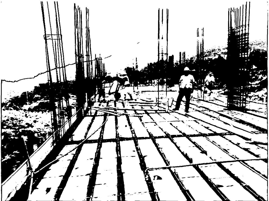
Figura 16 - P.F. Vaciado de concreto en la losa aligerada
