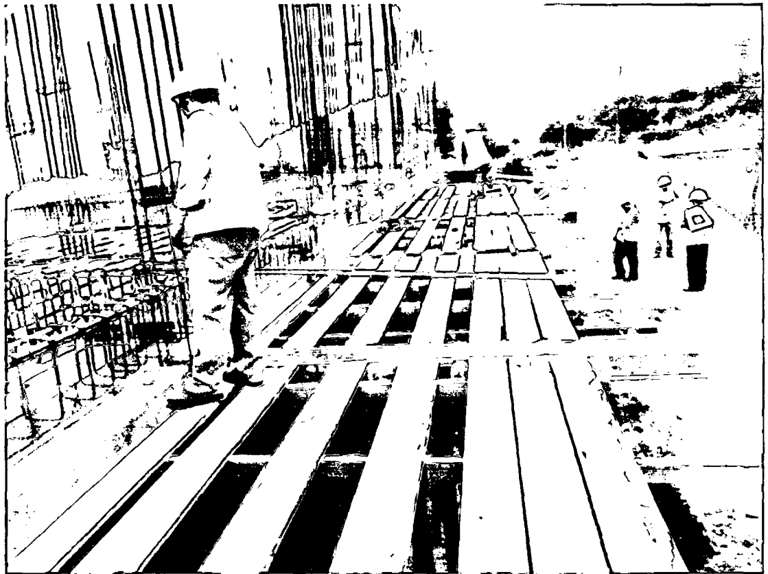
Figura 13 - P.F. habilitación de acero en las vigas
