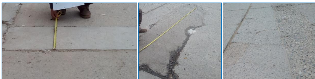
Figura N° 0 19: De izquierda a derecha, parcheo grande de baja, media y alta severidad.
