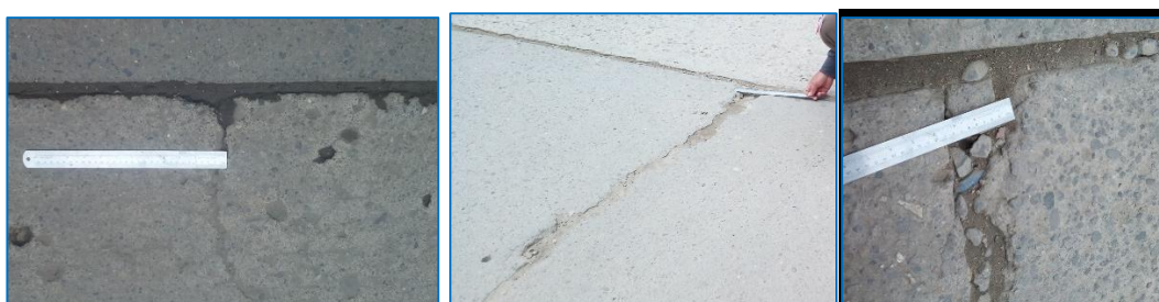
Figura N° 0 18: De izquierda a derecha, grietas lineales de baja, media y alta severidad.
