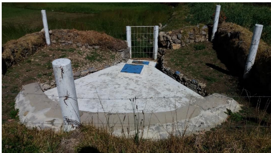
Figura 7. Captación Shiracpunta, Sistema de Agua Potable San Sebastián.
