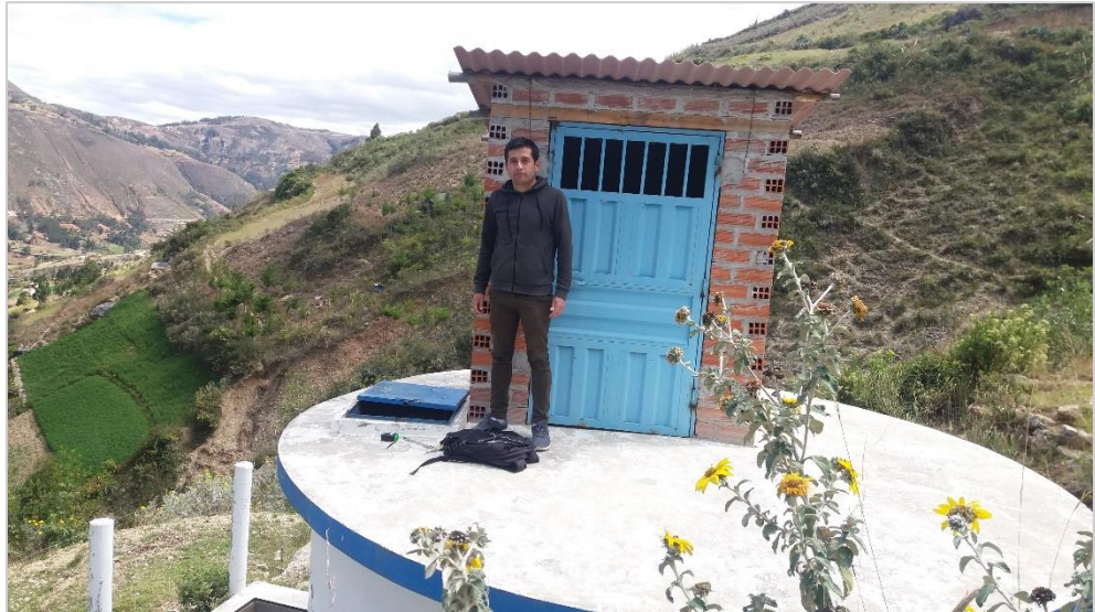
Figura 22. Vista de la caseta de cloración en el reservorio Bellavista
