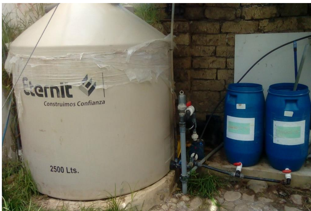
Fig. 9. Tanque de agua, para riego por goteo, ducha y tanques de fertilización.
