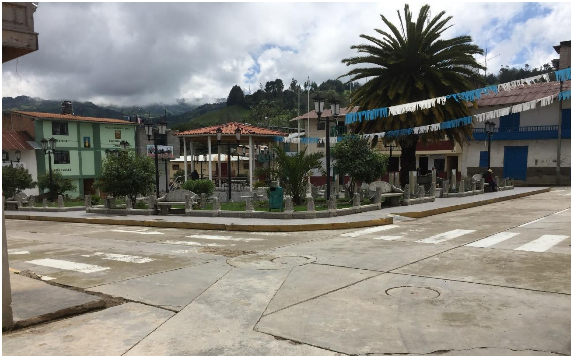
Fotografía 10: Plaza mayor del distrito de Chugur.
