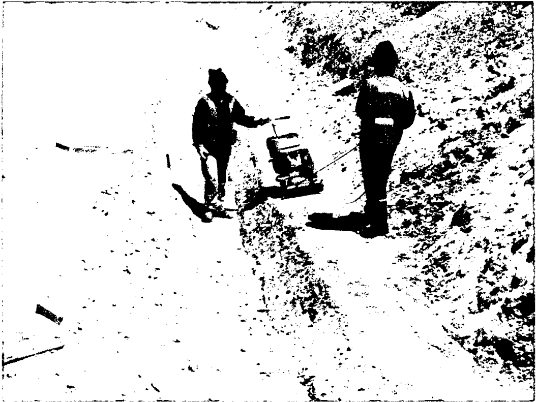
Fotografía N°17: Compactado y conformación de base, Sistema de Drenaje Stock Óxidos I, (Vialest S.A.C.)
