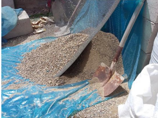
Imagen N° 1: Preparación de los agregados.
