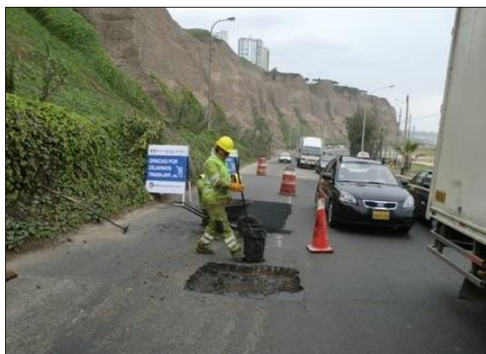
Figura 29: Trabajos en parchado superficial.
