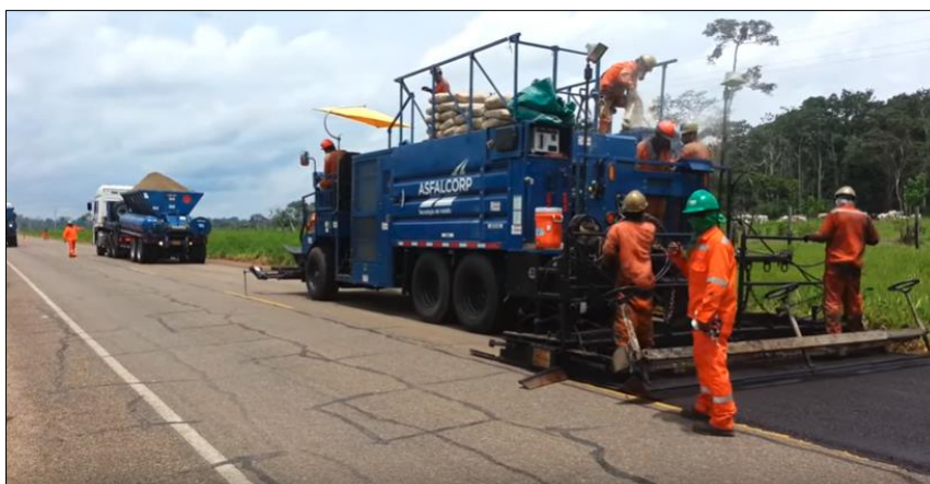
Figura 30: Aplicación de sello asfáltico mediante Slurry Seal en carretera IIRSA SUR.
