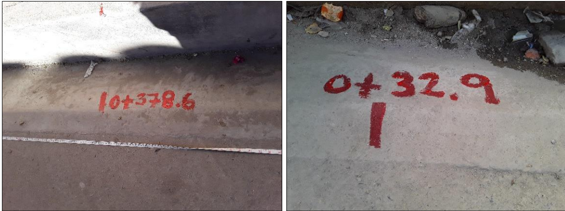
Figura 4: Marcado de progresivas en secciones 2 y 3.
