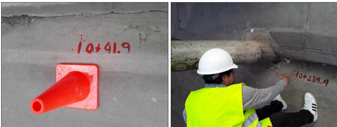
Figura 3: Marcado de progresivas en secciones 1 y 2.
