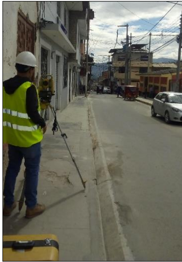
Figura 1: Levantamiento topográfico en el jirón Gregorio Malca cuadra 7.
