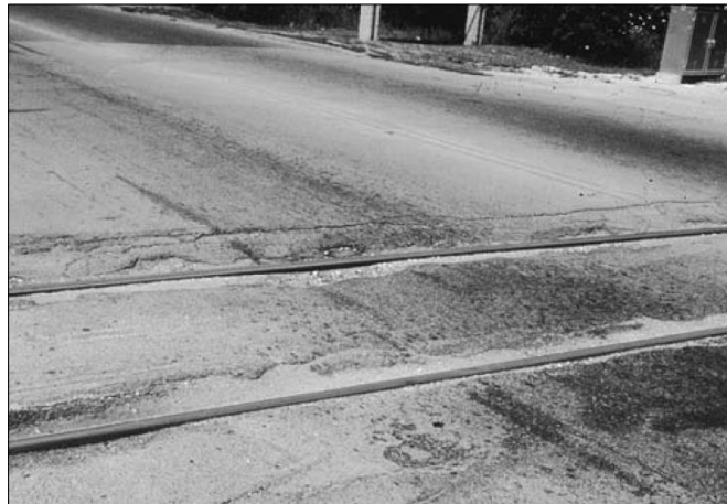
Figura 26: Cruce ferrocarril en calzada.
