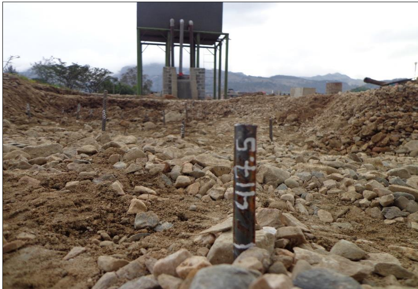
Figura 37. Ubicación de hitos de fierro en cada punto con su respectiva descripción de altura para proceder a obtener las curvas de nivel.
