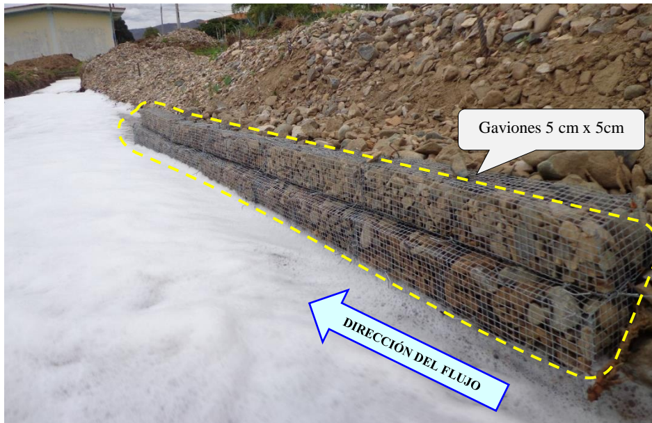
Figura 47: Incorporación de la estructura de gavión a escala (1:20) en el modelo.
