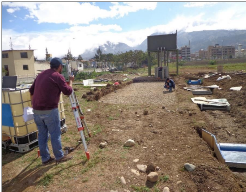
Figura 36. Replanteo de las cotas topográficas y batimétricas mediante una Estación Total Leyca TS06 con precisión 0.1 mm.
