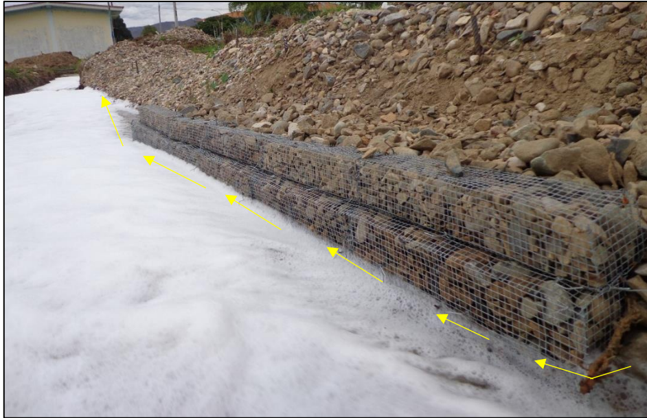
Figura 55. Comportamiento del flujo con estructura de gavión en el modelo físico.
