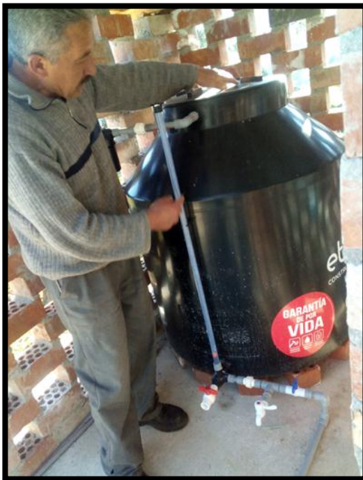
Figura 18. Instalación de sistema de cloración del reservorio (actualmente sin funcionamiento)
