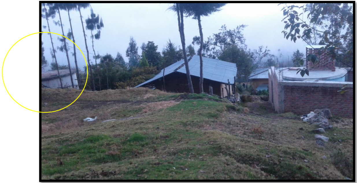
Figura 17. Tanque alternativo para acumulación del agua de Oxamarca-Celendín, actualmente sin funcionamiento.
