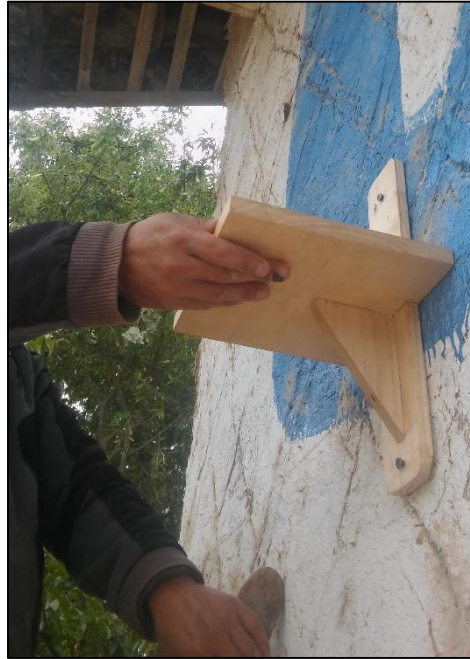
Figura 6. Instalación previa de soportes para placa receptora de vidrio.
