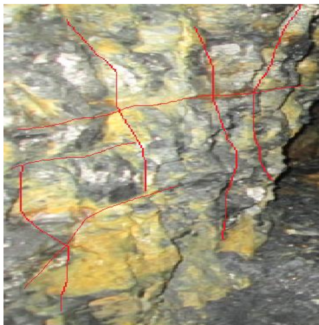
Foto 19: Ventana 5 presenta 7 discontinuidades
