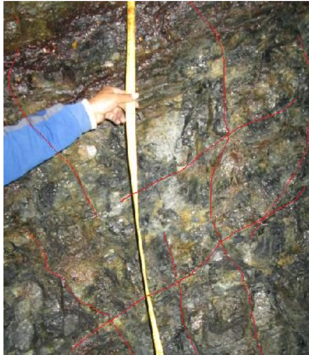
Foto 18: Ventana 4 presenta 7 discontinuidades
