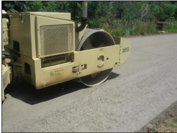
Figura N° 1: Compactación del concreto con rodillo vibratorio Fuente: Portland Cement Association – PCA (2006)
