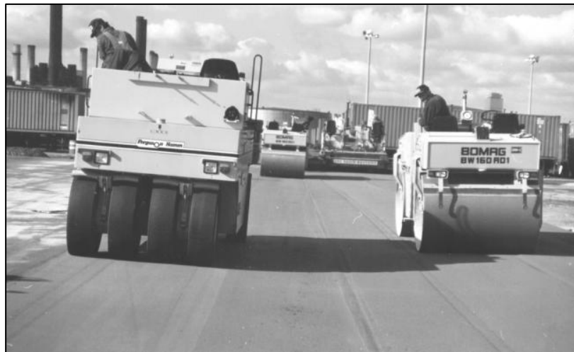
Figura N° 8: Rodillo compactador de neumáticos y rodillo vibratorio
