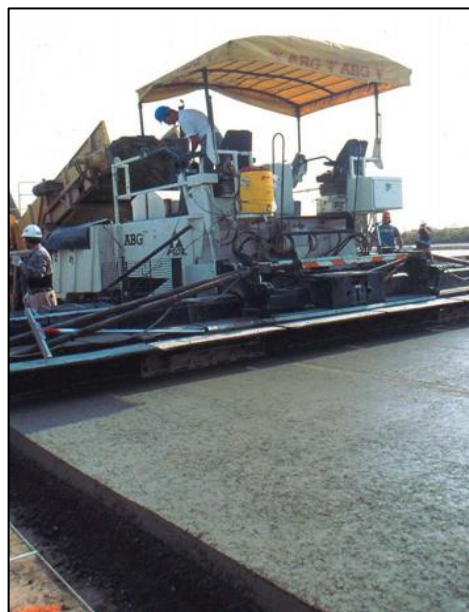
Figura N° 2: Distribución del concreto con equipo para mezclas asfálticas Fuente: Portland Cement Association – PCA (2006)
