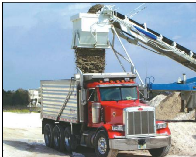
Figura N° 6: Colocación del concreto de la central en camión para su transporte a obra Fuente: Portland Cement Association – PCA (2006)
