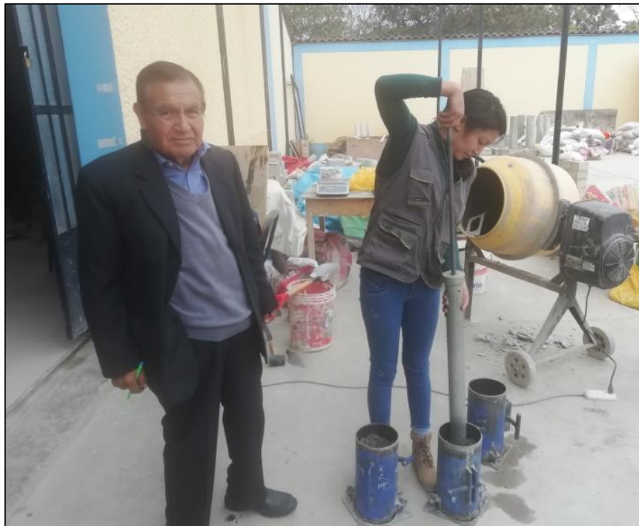
Fotografía N° 18: Elaboración y compactación de los especímenes de concreto.
