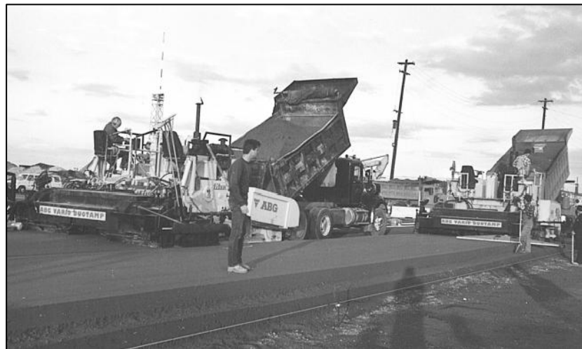
Figura N° 7: Colocación del CCR utilizando máquinas de asfalto modificados
