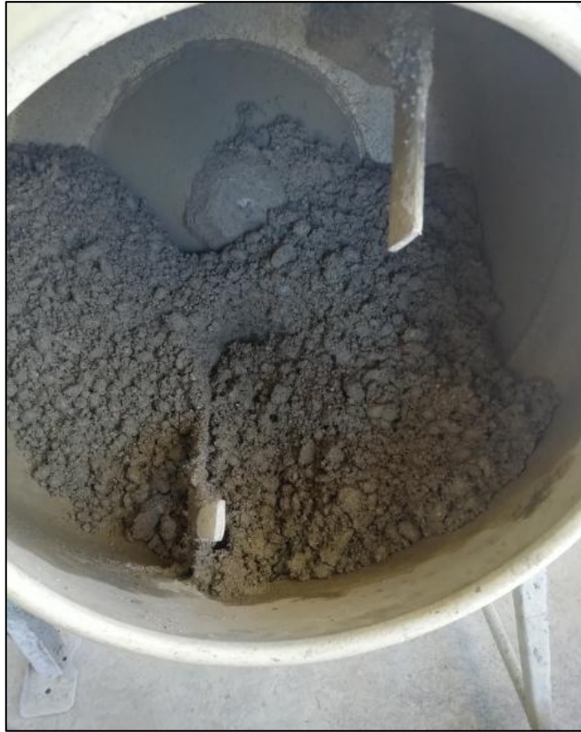
Fotografía N°17: Mezclado de materiales del concreto
