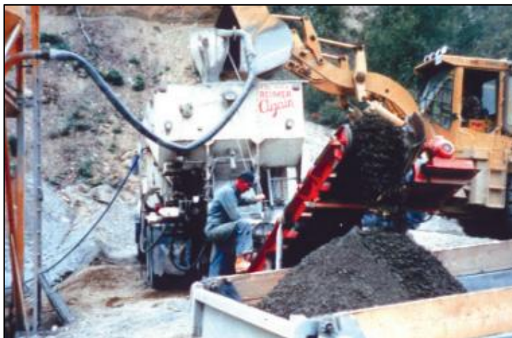
Figura N°4: Método discontinuo con mezcladores de tránsito o mixer Fuente: Portland Cement Association – PCA (2006)
