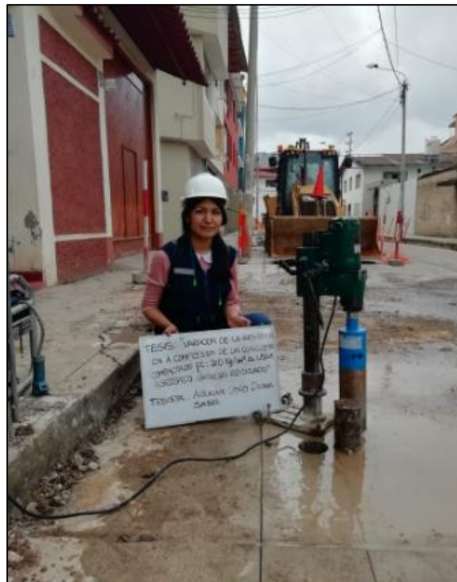
Fotografía N° 2: Extracción de núcleo de concreto endurecido
