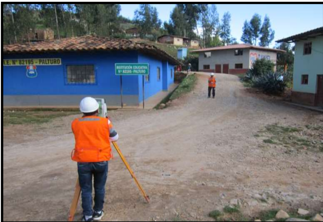
Fotografía N° 28: Toma de datos del eje de camino vecinal del km 02+500 al km 03+000.
