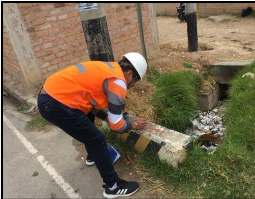
Fotografía N° 2: Materialización de BM 01 en campo.
