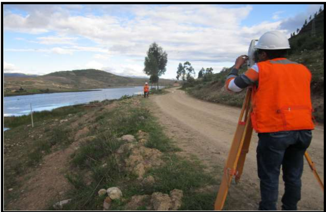
Fotografía N° 32: Toma de datos del borde del camino vecinal del km 00+000 al km 01+500.
