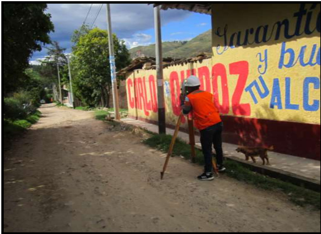
Fotografía N° 8: Levantamiento de la sección del camino vecinal Km 00+500 al km 01+00.
