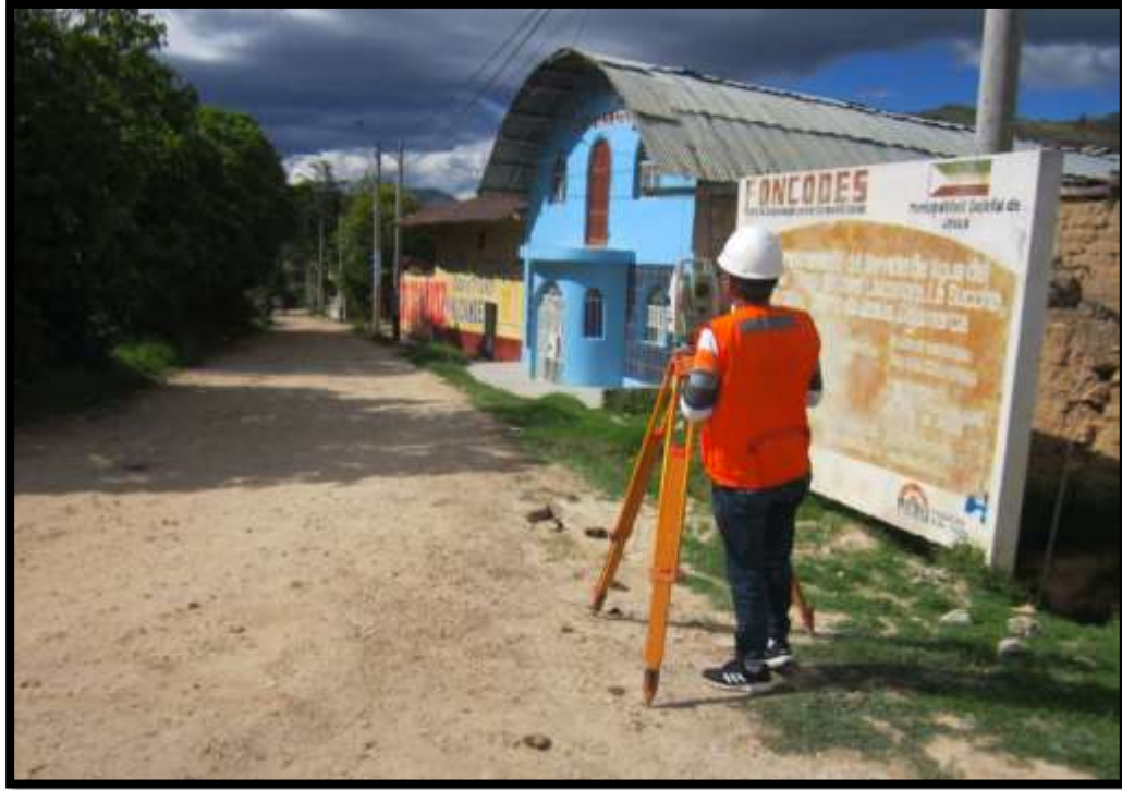
Fotografía N° 7: Estacionamiento para levantamiento del km 09+000 al km 09+500.
