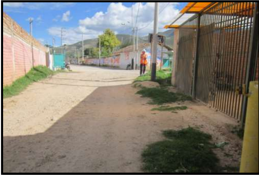
Fotografía N° 3: Ubicación del prisma en el borde del camino vecinal, intersección con la carretera hacia Jesús.
