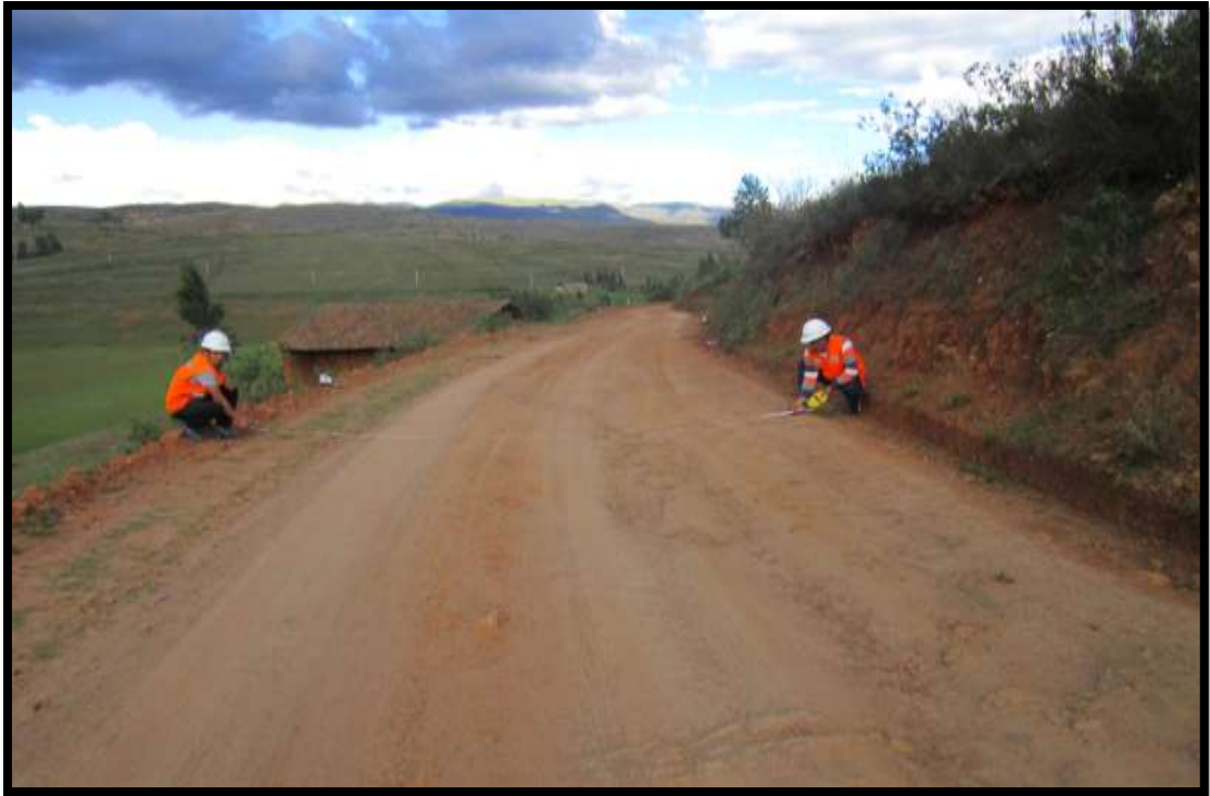
Fotografía N° 31: Toma de datos del ancho de plataforma.
