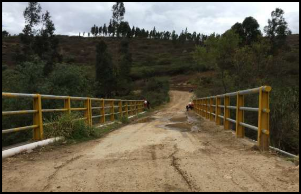
Fotografía N° 17: Toma de datos del ancho de calzada a la altura del puente.
