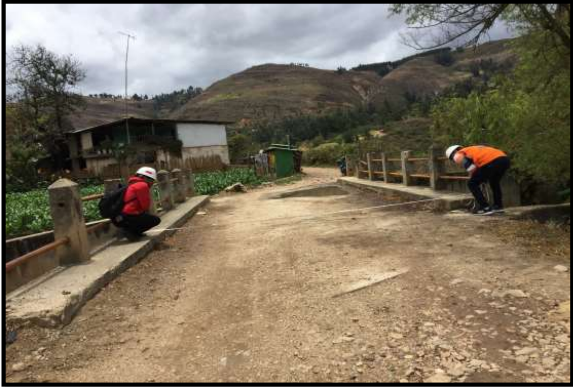
Fotografía N° 13: Toma de datos del ancho de pontón.
