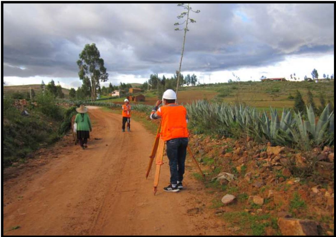
Fotografía N° 30: Toma de datos del eje de camino vecinal del km 01+500 al km 02+000.
