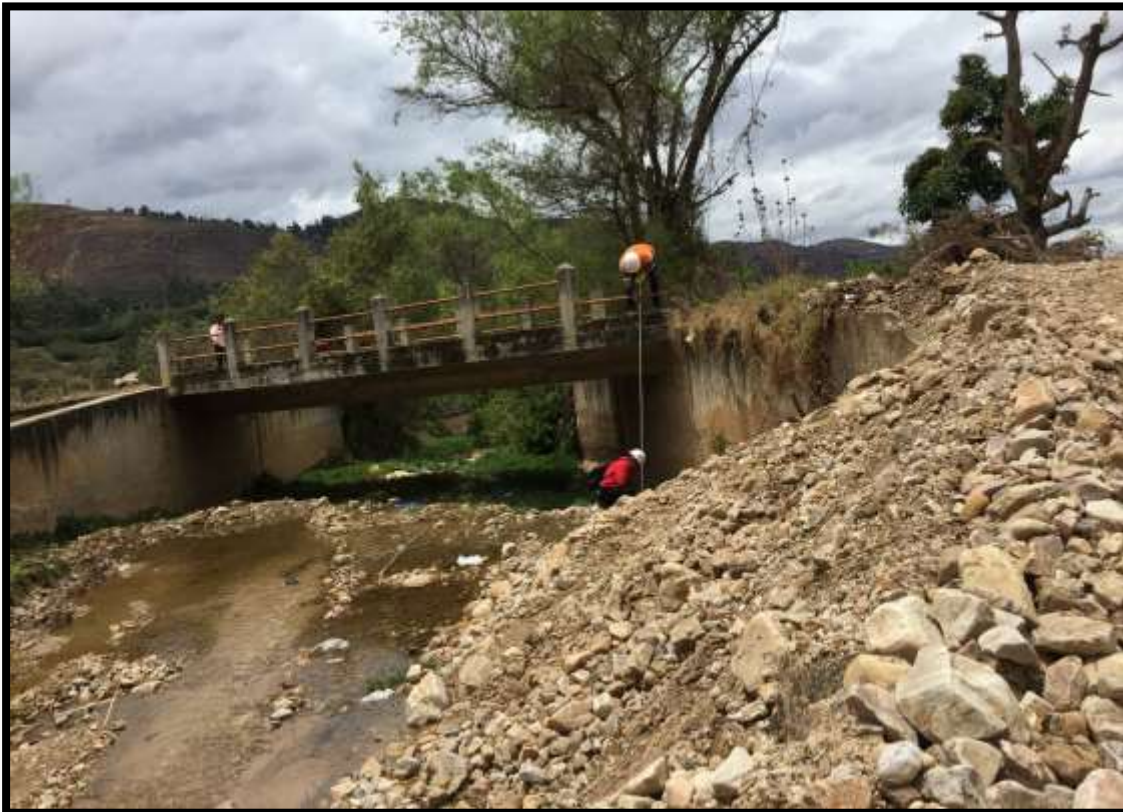
Fotografía N° 14: Toma de medidas de la sección de pontón.
