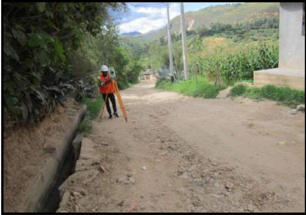
Fotografía N° 9: Estacionamiento para levantamiento del km 08+500 al km 09+000.
