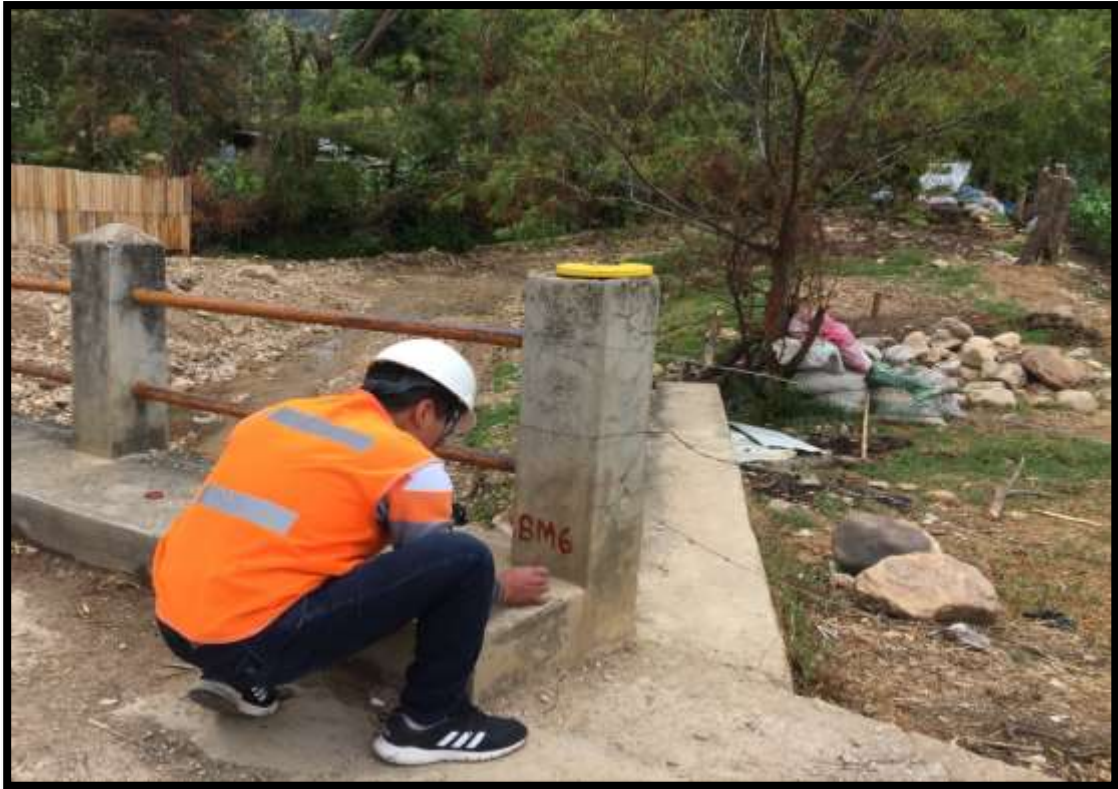
Fotografía N° 15: Materialización de BM 06 en campo.
