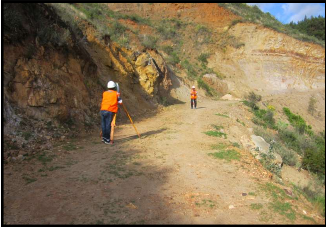
Fotografía N° 25: Toma de datos del eje de camino vecinal del km 05+500 al km 06+000.
