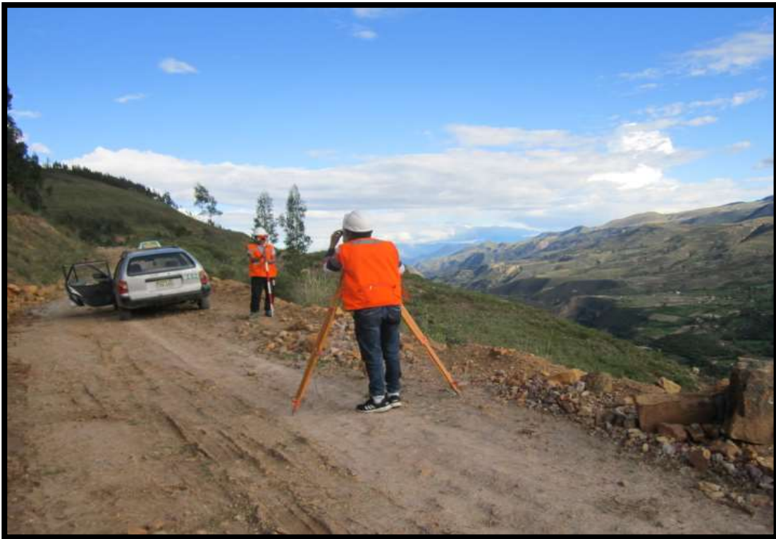
Fotografía N° 26: Toma de datos del borde del camino vecinal del km 04+000 al km 05+500.
