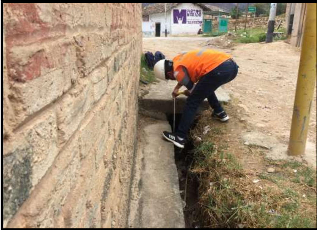
Fotografía N° 5 : Toma de medidas de la sección transversal de alcantarilla n° 02.
