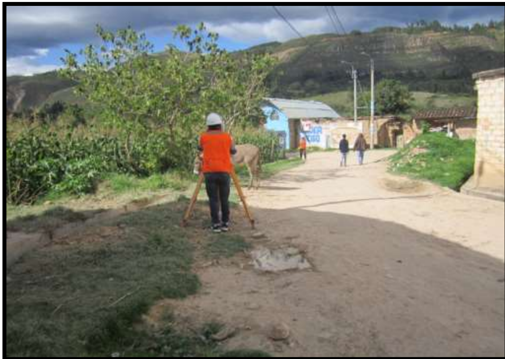
Fotografía N° 6 : Levantamiento de la sección de la curva horizontal C180 progresiva 09+882.13.
