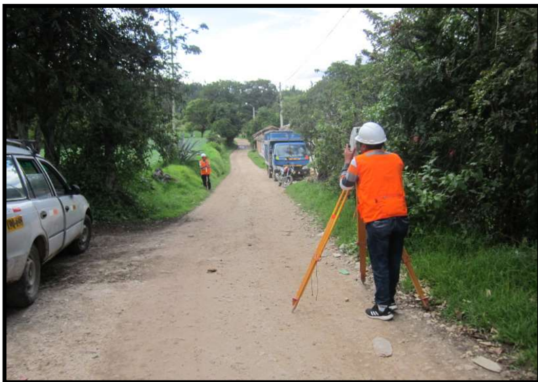
Fotografía N° 11: Levantamiento de la sección del camino vecinal del km 08+00 al km 08+500.
