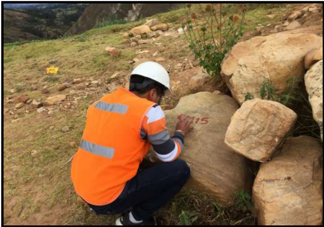
Fotografía N° 22: Materialización de BM 15 en campo.
