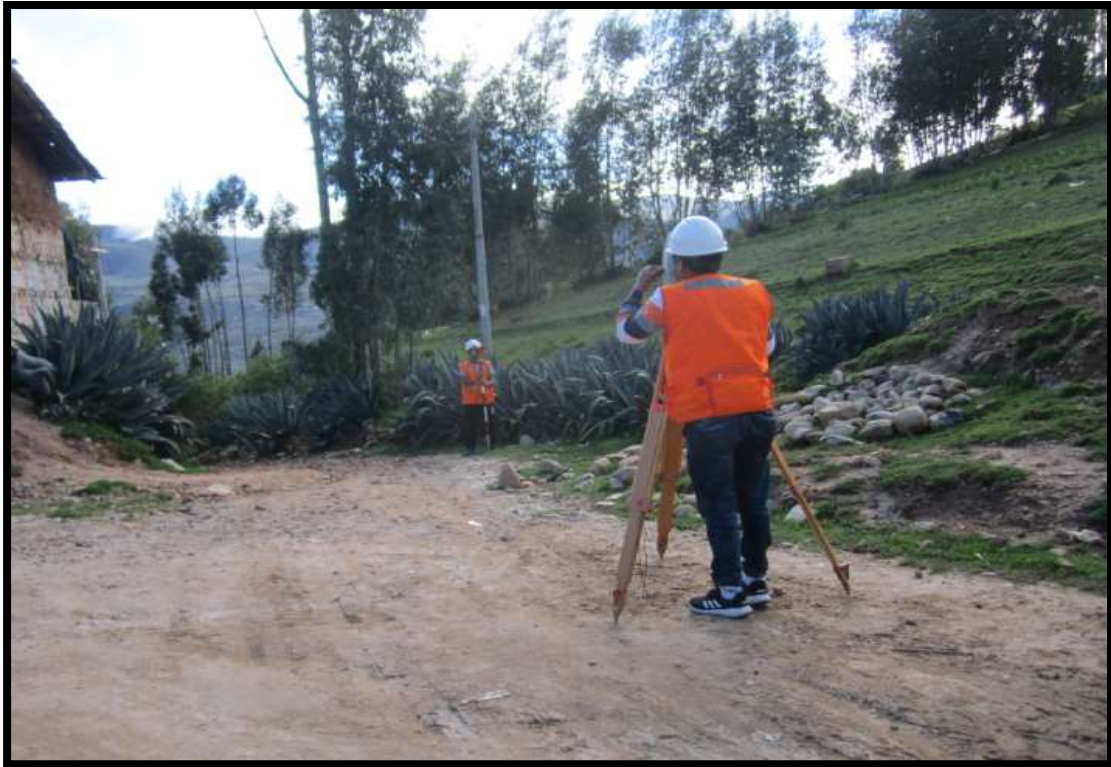
Fotografía N° 27: Toma de datos del borde la carretera del km 03+000 al km 04+000.
