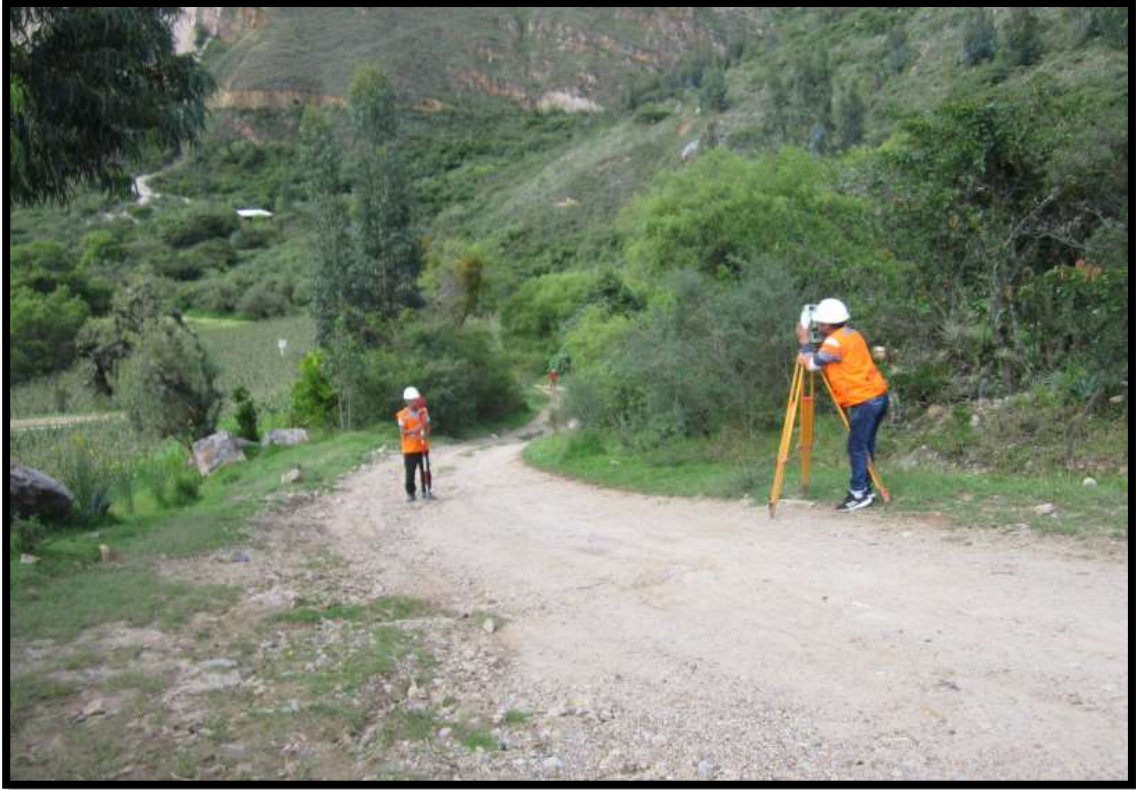
Fotografía N° 19: Toma de datos del eje en curva.
