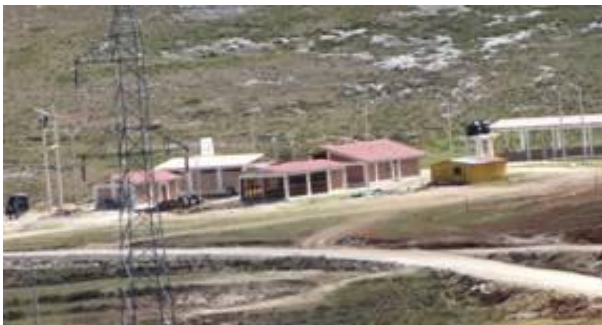
Figura 2. Planta de Tratamiento de Residuos, carretera Cajamarca – Cajabamba
