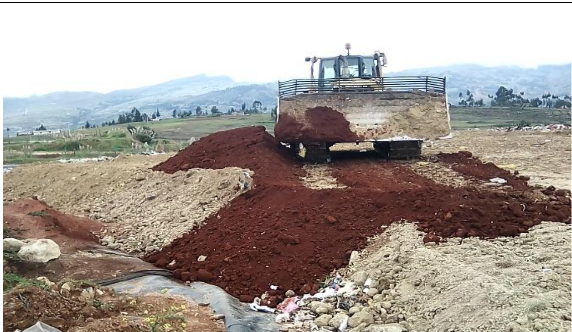
Figura 6. Sellado final de residuos sólidos.
