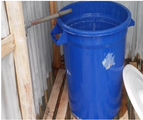
Figura N° 12. Tubería para llenado del balde
