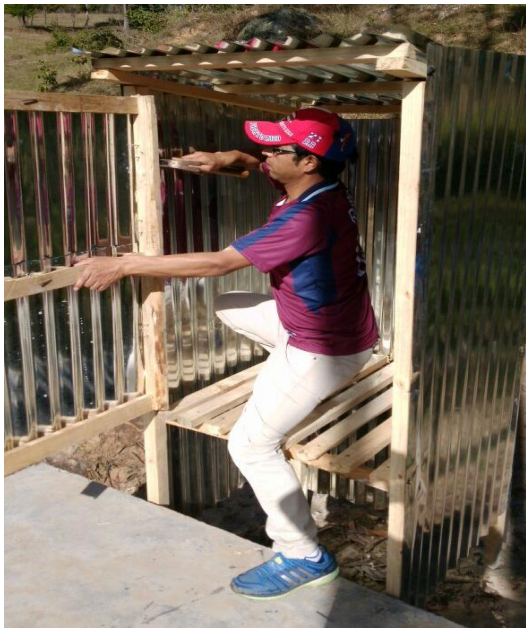
Figura N° 10. Construcción de caseta de protección para el sistema de cloración
