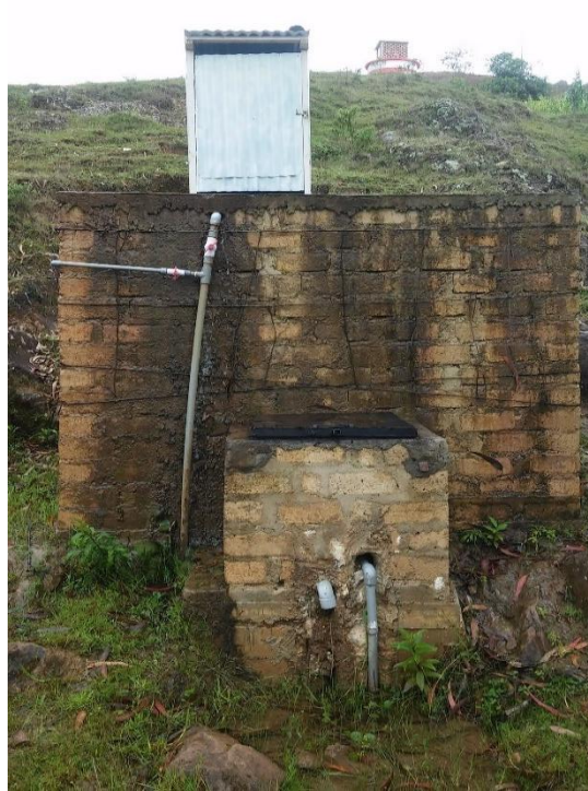
Figura N° 9. Reservorio del agua de Caucha
