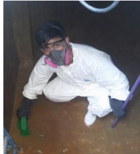
Figura N° 15. Limpieza interior del reservorio
