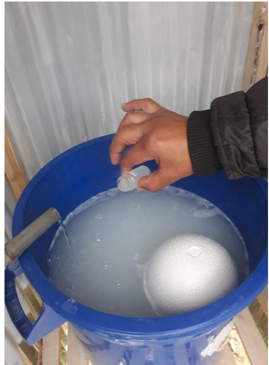
Figura N° 18. Preparación de la solución clorada para el sistema de goteo
