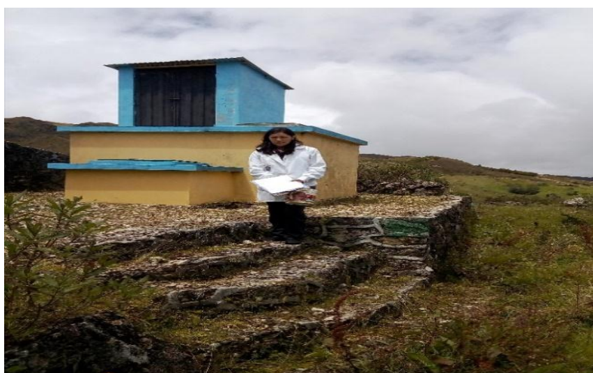
Figura 22. Inspección del reservorio
