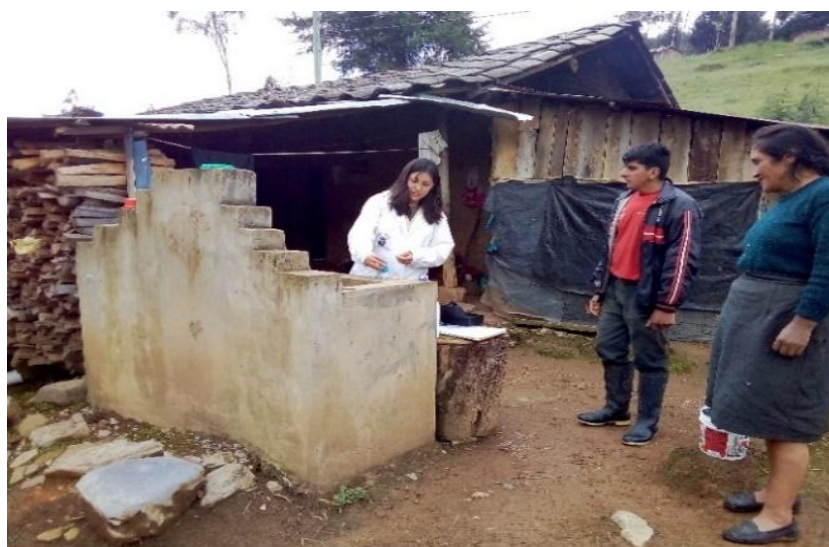
Figura 29. Cámara rompe presión del sistema
