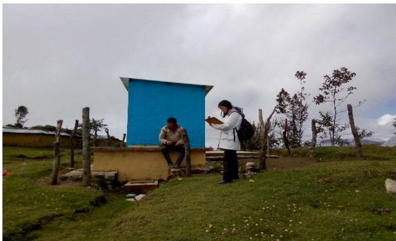
Figura 16. Inspección del Reservorio
