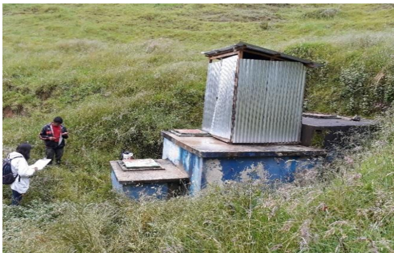
Figura 27. Captación 01 del sistema
