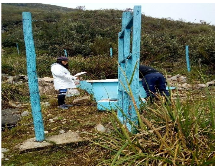
Figura 30. Captación de agua
