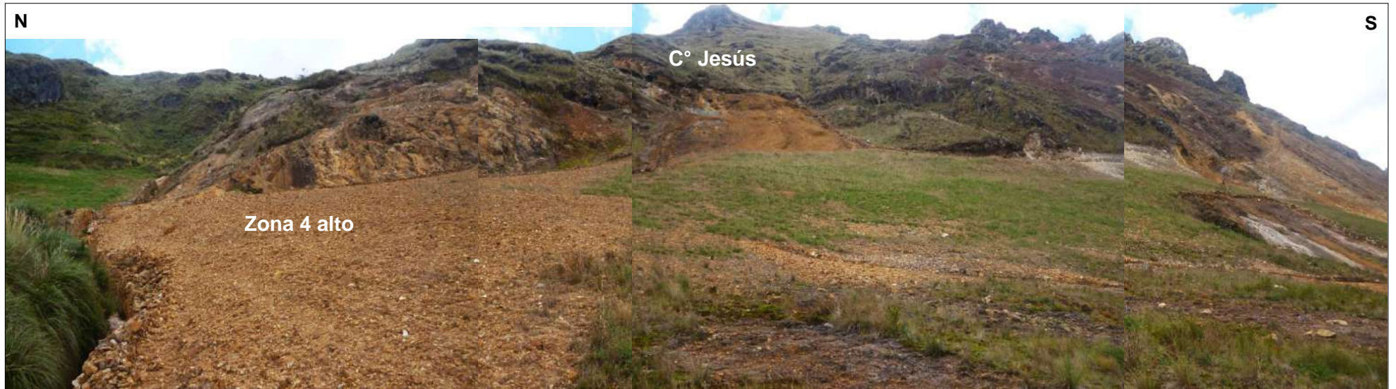
Figura 60: Zona 4 y zona 5 de pasivo ambiental (sólido) parte alta lado NNW. del C° Jesús, se aprecia \pm 50\% de remediación en PMA 'S
