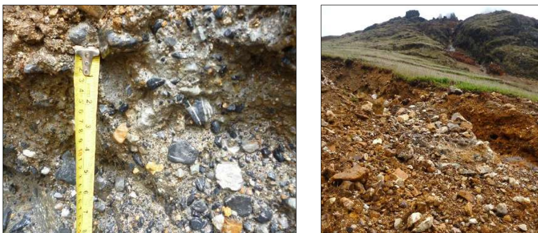
Figura 17. Sedimentos cuaternarios coluvio- aluvial (natural -foto Izq.), constituidos por limos arcillas, clastos de calizas, areniscas y óxidos; ubicado en las laderas del C° Jesús (antrópico -foto Derech).
