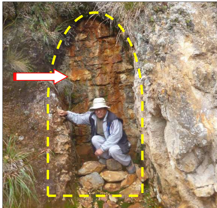
Figura 48. Boca mina con sello de mampostería para evitar la generación de drenaje ácido (plan de cierre), con hastiales de roca caliza en la Fm. Yumagual; Mesa de Plata cerca al punto de monitoreo MP-2.
