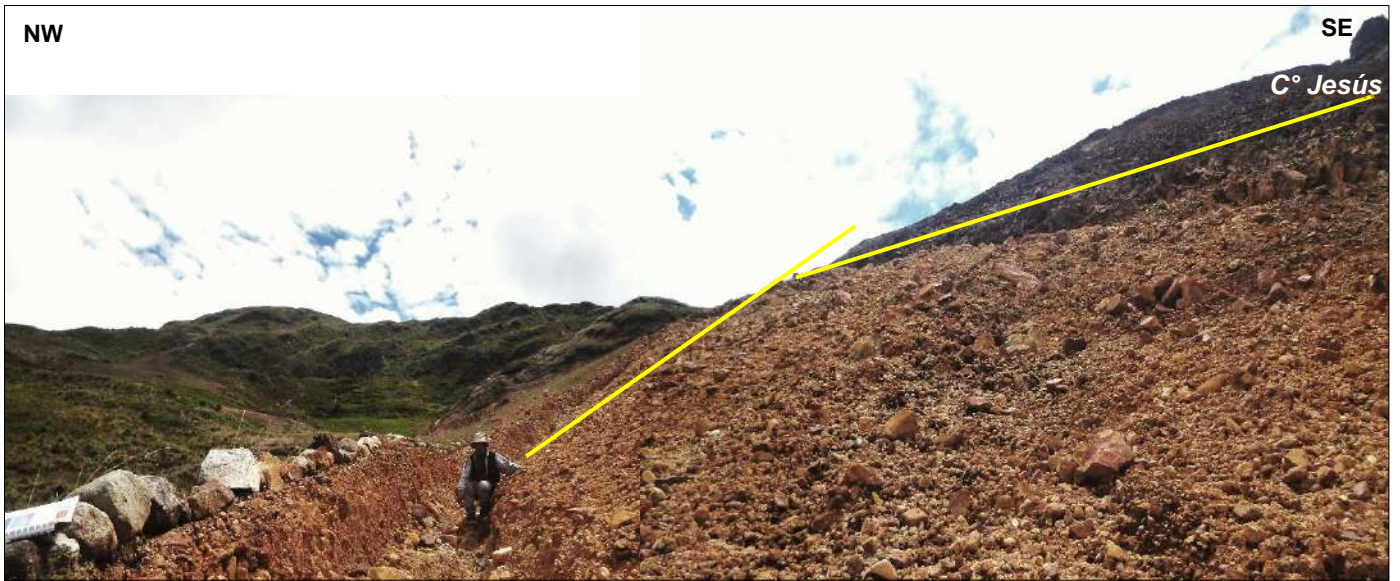
Figura 58: Zona 4 de pasivo ambiental sin remediar constituidos por bloques, cantos, gravas, arena, limos, arcillas y clastos de óxidos, sulfuros, intrusivo entre otros en el talud que varía de 20 -45° de pendiente.
