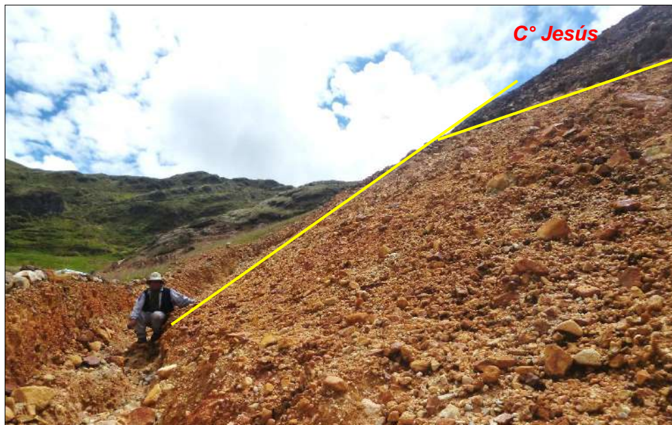
Figura 57. Zona 4 de pasivo ambiental sin remediar constituidos por bloques, cantos, gravas, arena, limos, arcillas y clastos con óxidos de hierro, sulfuros entre otros en talud de 20 -45° de pendiente.
