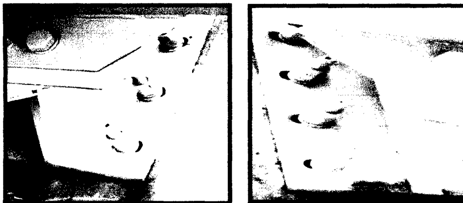
Foto1. Se observa la presencia de ojos chinos en los apoyos de las rotulas.
