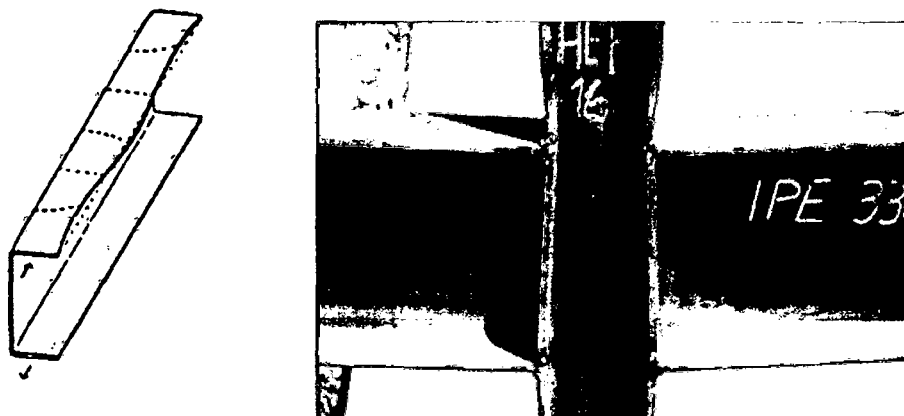
Figura 21. Se observa que el elemento sufre abolladura, es decir, se deforma normalmente a su plano, lo que reduce la sollicitación de agotamiento. (Referencia, Begonia Serrano Lanzarote, Lesiones y síntomas en estructuras de acero y madera, 33 diapositivas).
