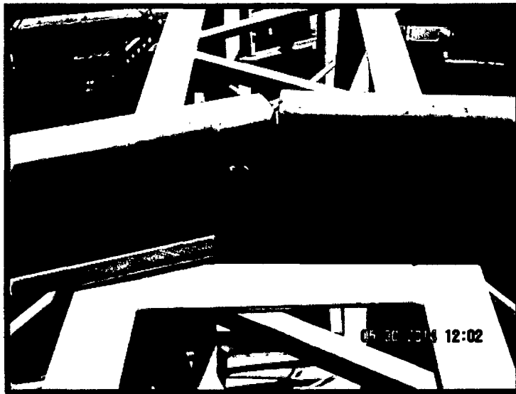
Foto 3. Se observa la separación mayor de 1cm entre las vigas c.
