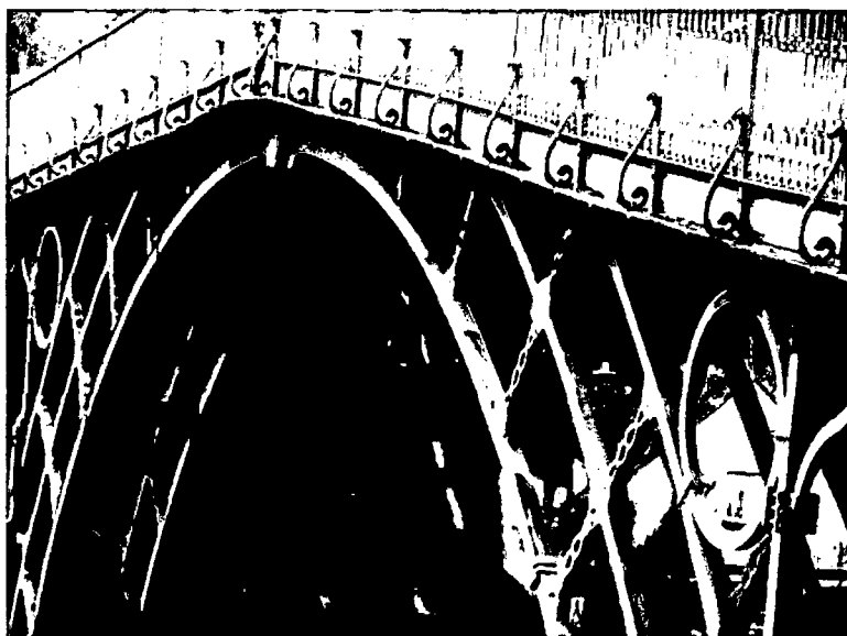
Figura 5. Puente Shropshire sobre el río Severn, en Coalbridge, Gran Bretaña.
